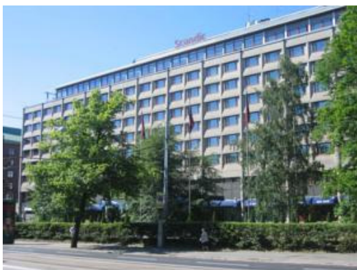
Kuva 3. Hotelli Scandic Parkin julkisivu ennen korjaustöiden alkamista
