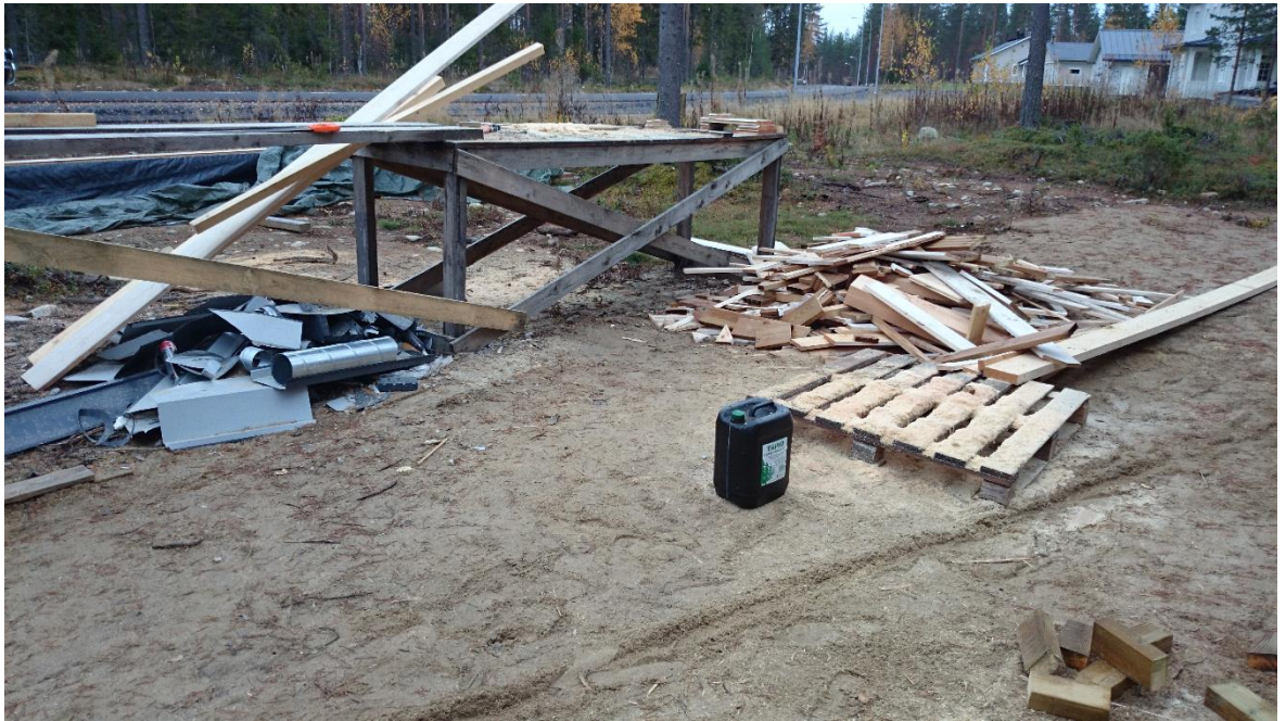
Kuva 1. Roskat lajiteltuna työmaan reunalla.
