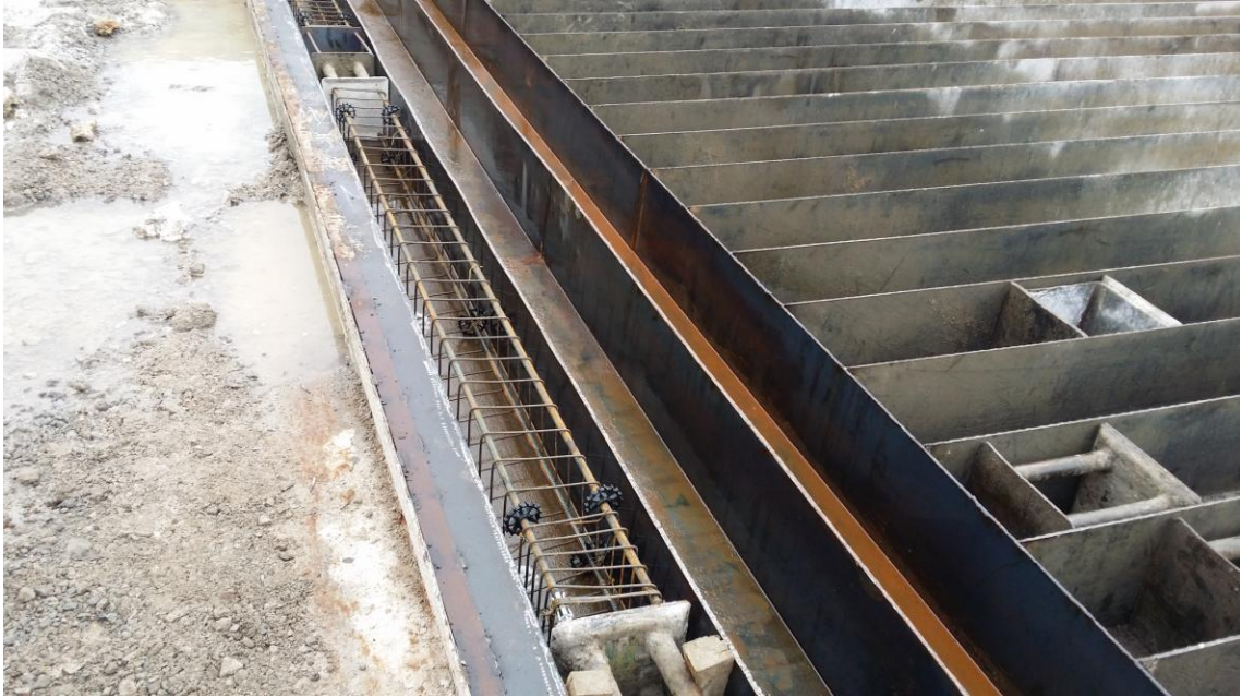
Kuva 6. Muotti valmisteltu valuun.
