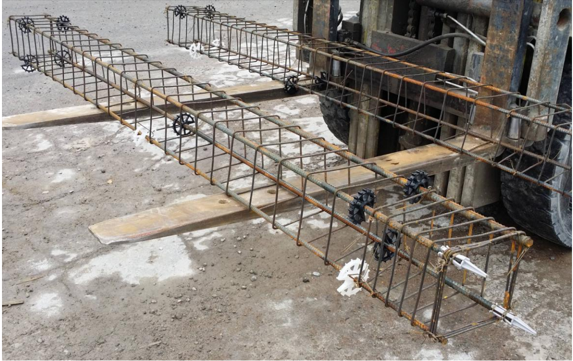
Kuva 5. Valmis raudoite välikkeineen.
