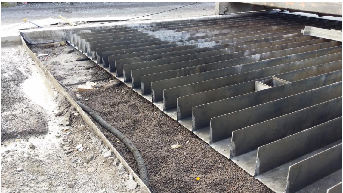
Kuva 2. Muotisto on lyhennetty ja poistettu.
