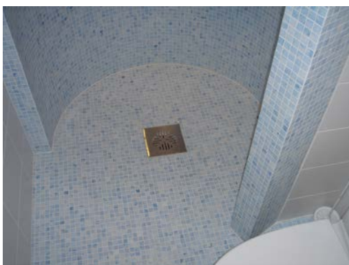
KUVA 14. Kaaren laatoitus
