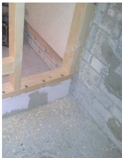
KUVA 5. Vanha Kahi –tiilinen seinä
