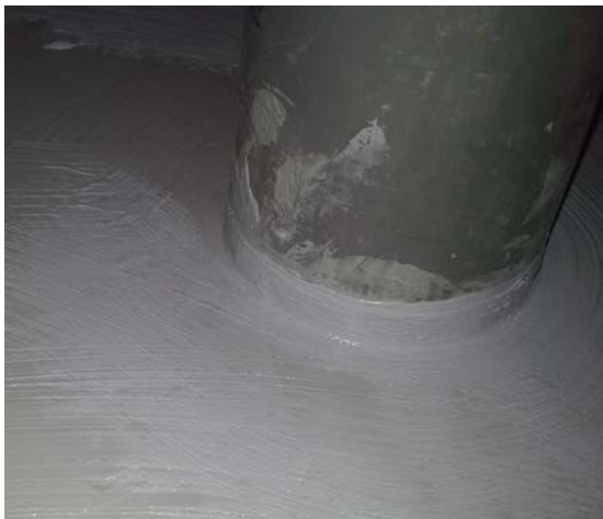
KUVA 11. Putken vedeneristys
