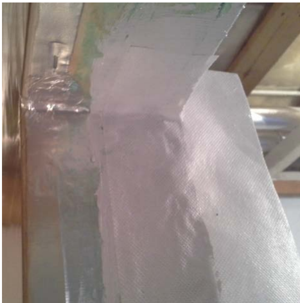
KUVA 12. Oviaukon vedeneristys
