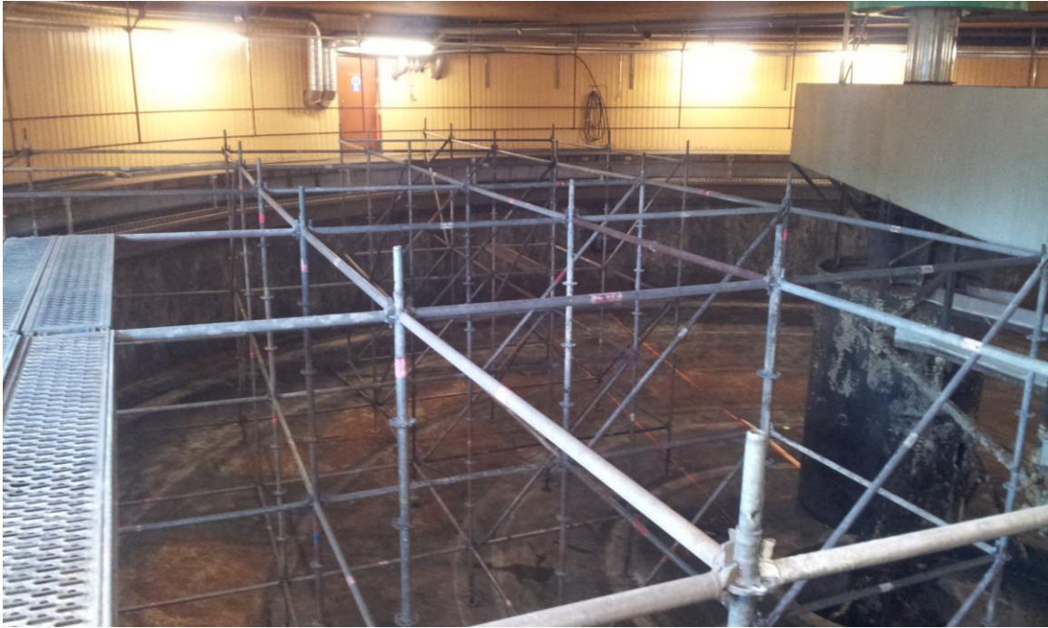
KUVA 1. Paikalla rakenteella olevat sauvamoduuliteräspuitelineet
