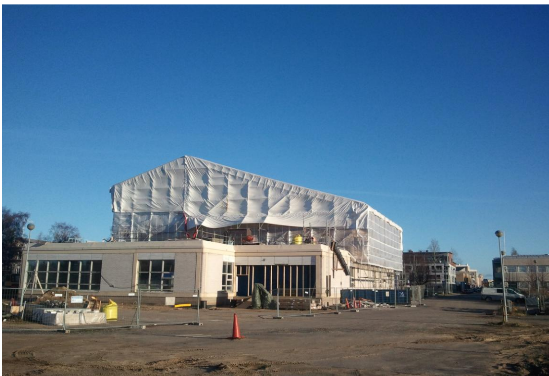
KUVA 11. Raahen pääkirjaston saneeraustyömaa oli sääsuojaukselta ja rakennustelineiltä Ramirent Finland Oy:n kohde Raahessa
