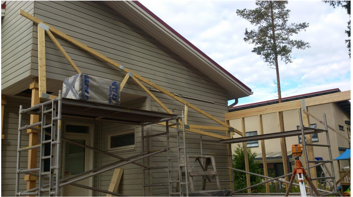
Kuvio 15. Ensimmäinen kattoristikko valmiina seinään kiinnitykseen
