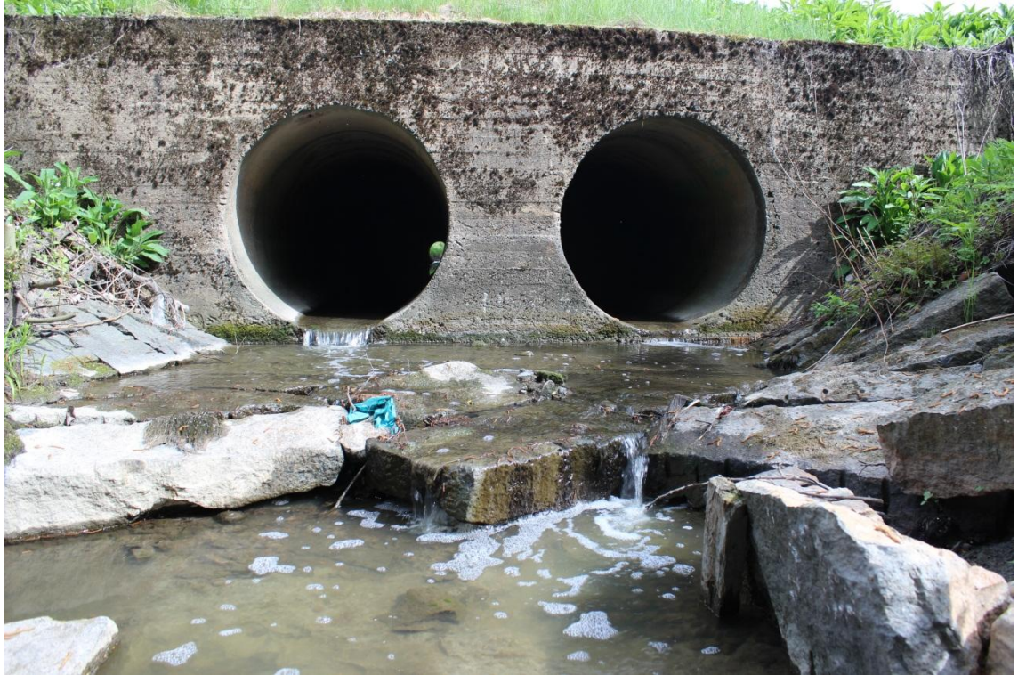
Kuva 14. Naantalin pikatien alittavat putket ja isokokoisia kivilaattoja.
