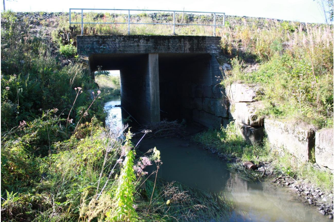
Kuva 23. Radan alle on rakennettu mittava tunneli tulvavesille.
