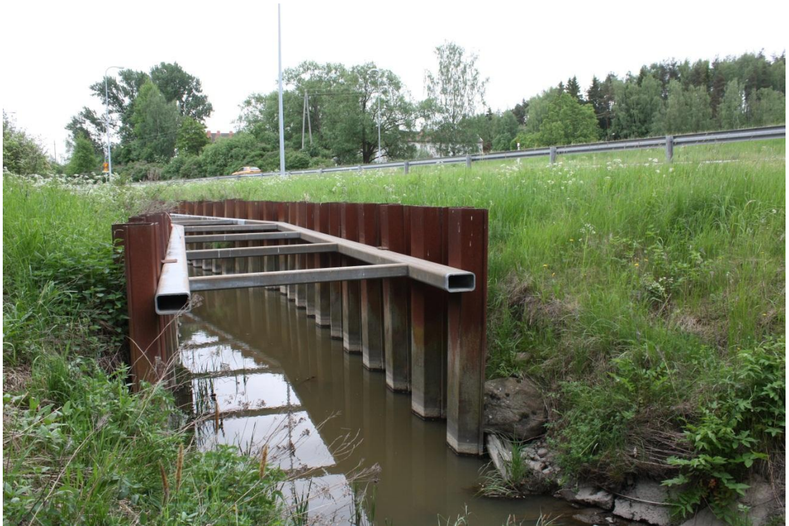
Kuva 22. Erosiosuojaus Naantalintien vieressä vähentää reunojen kulumista.
