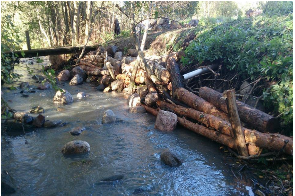
Kuva 3. Puunrungot tukevat Longinojan reunoja Ala-Malmin Saunankoskella (kuva J. Salonen).
