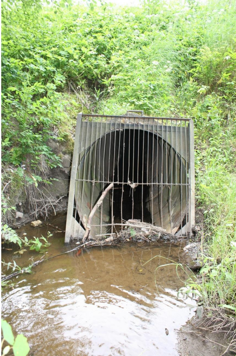
Kuva 16. Kuninkojan uoman ainoa putken suulle asetettu ritilä.
