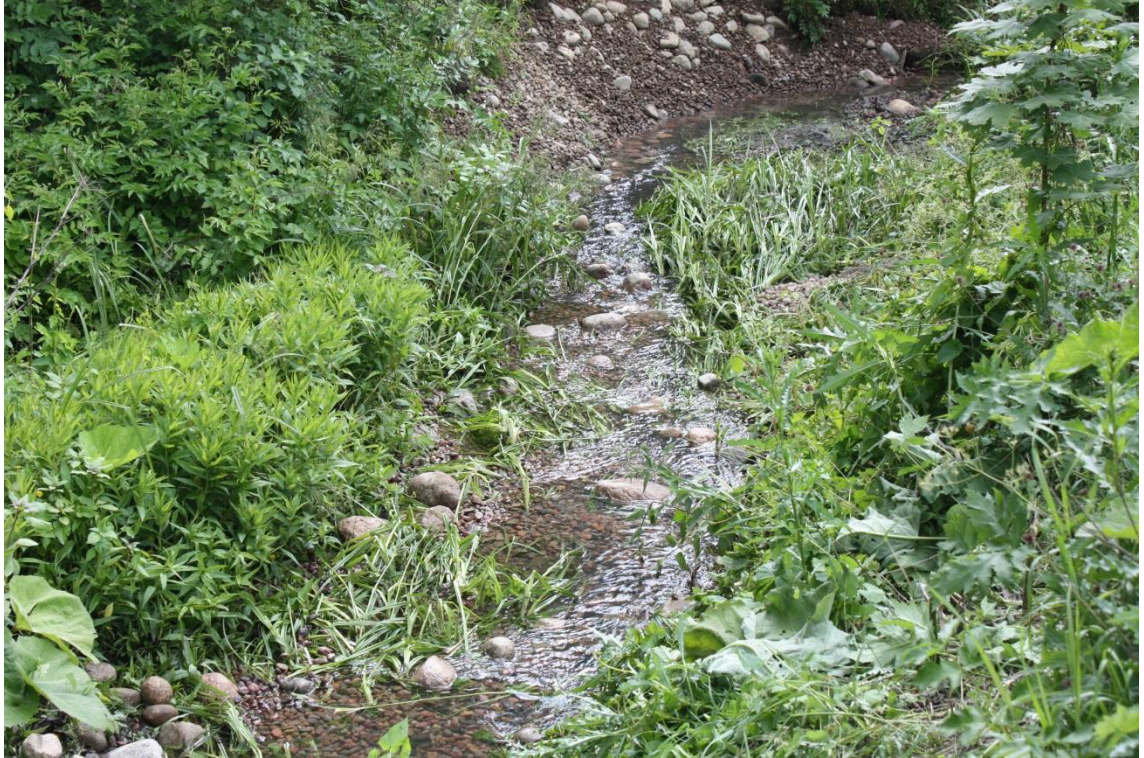
Kuva 29. Kovasojan talkookohteen profiili monipuolistui kunnostuksen jälkeen.
