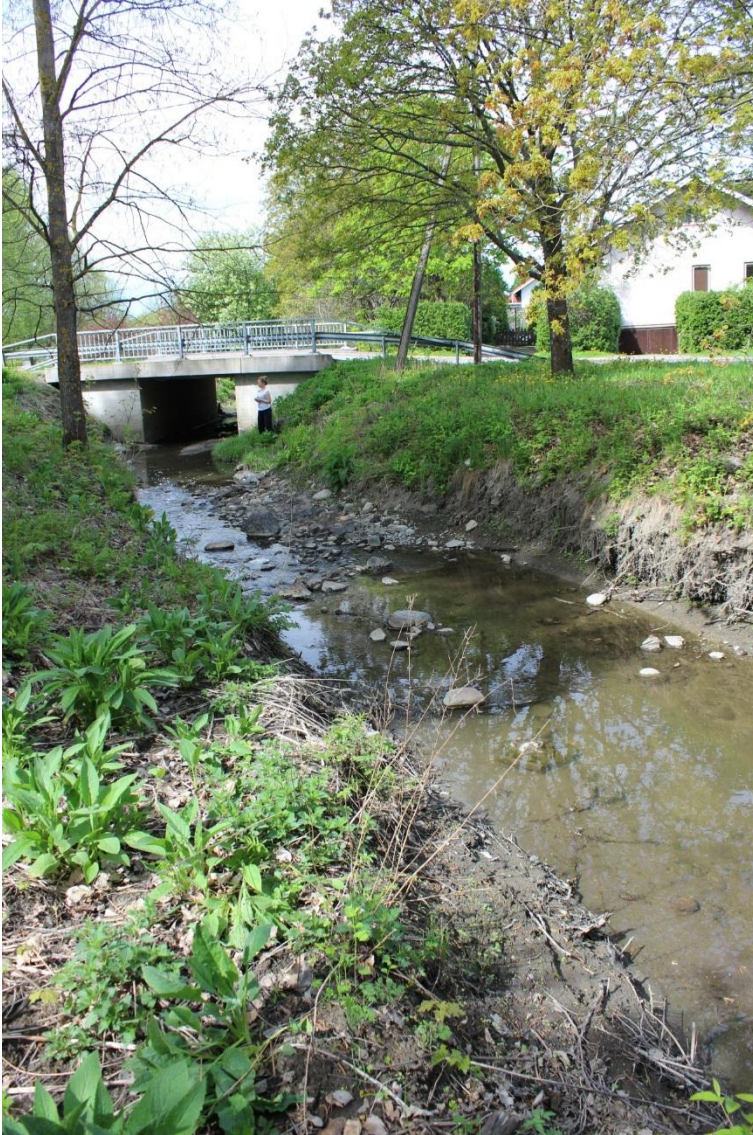
Kuva 13. Saukonojan tulvien aiheuttamaa eroosiota (kuva J.Tolonen).
