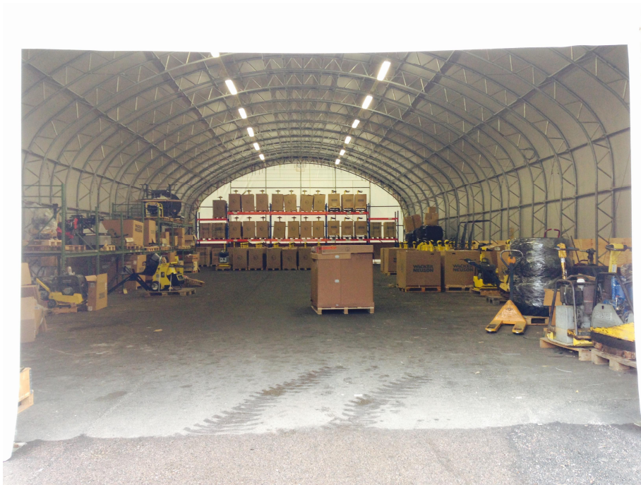
Kuva 4: Ulkovarasto, Edeco-Tools Oy.
