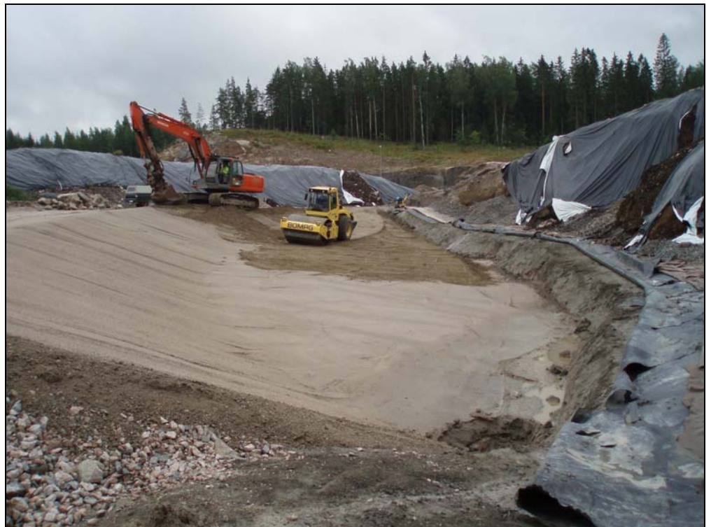
Kuva 23. Mineraalisen tiivistyskerroksen 1. kerroksen rakentamista
