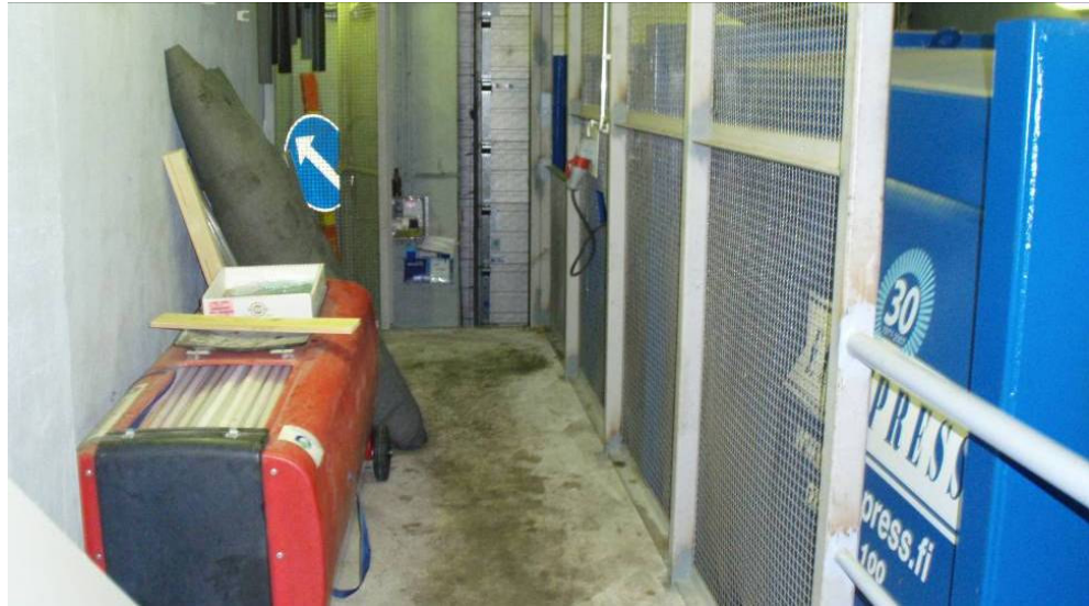
Kuva 26 Hammareninkatu 2 lastaussillalle on kertynyt ylimääräistä tavaraa. Punainen säiliö on loisteputkien keräystä varten.
