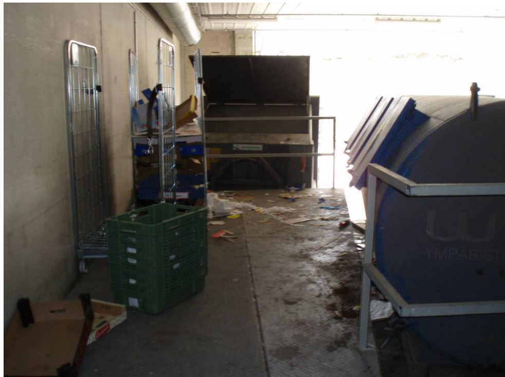
Kuva 22 Ukkopekankatu 5 lastaussillalla on ylimääräistä tavaraa. Puristimen edessä on aita turvallisuuden parantamiseksi. Oikealla biojättesäiliö.
