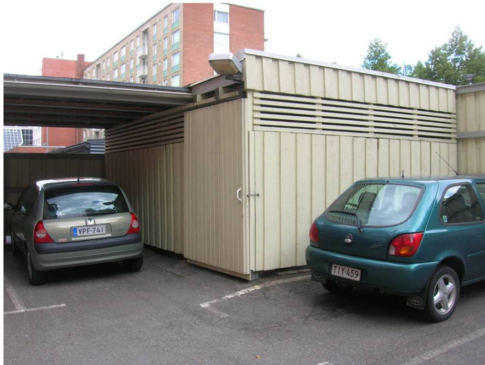
Kuva 8 Pinninkatu 51:n jätekatos sijaitsee sisäpihalla parkkipaikan perällä
