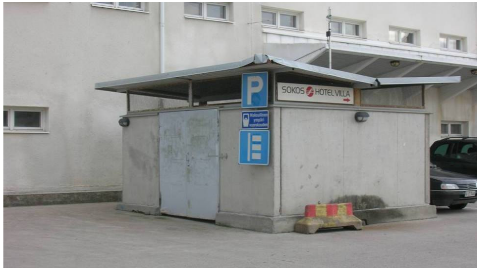
Kuva 18 Tullikatu 6:n keräyspiste on jätekatoksessa parkkipaikan laidalla.
