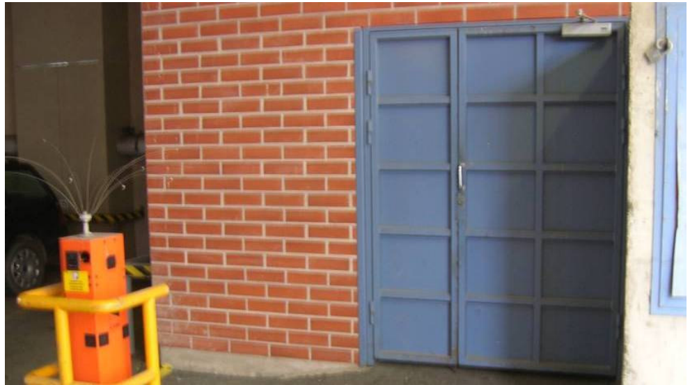
Kuva 10 Yliopistonkatu 44:n jätehuoneen ovi parkkipaikan puolelta
