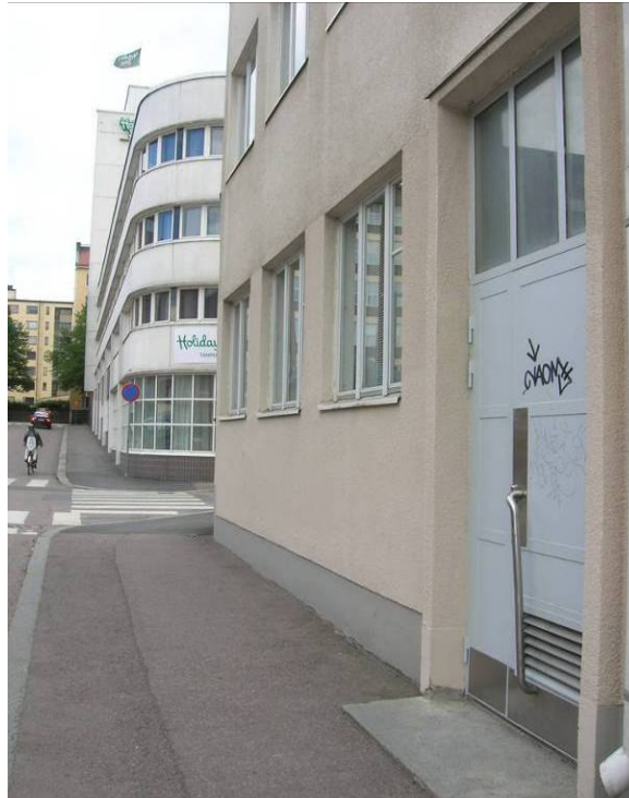
Kuva 24 Hammareninkatu 5:n jäteastiat on helppo kuljettaa jätehuoneen matalan kynnyksen yli.
