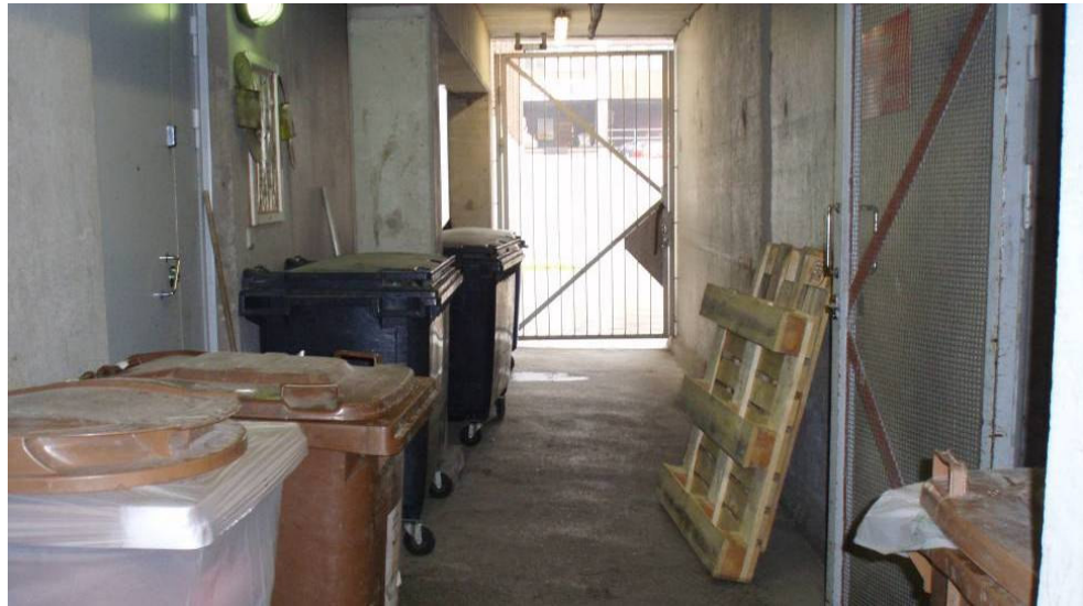
Kuva 15 Åkerlundinkatu 8 keräyspisteessä käytävällä on jäteastioita ja ylimääräistä tavaraa.
