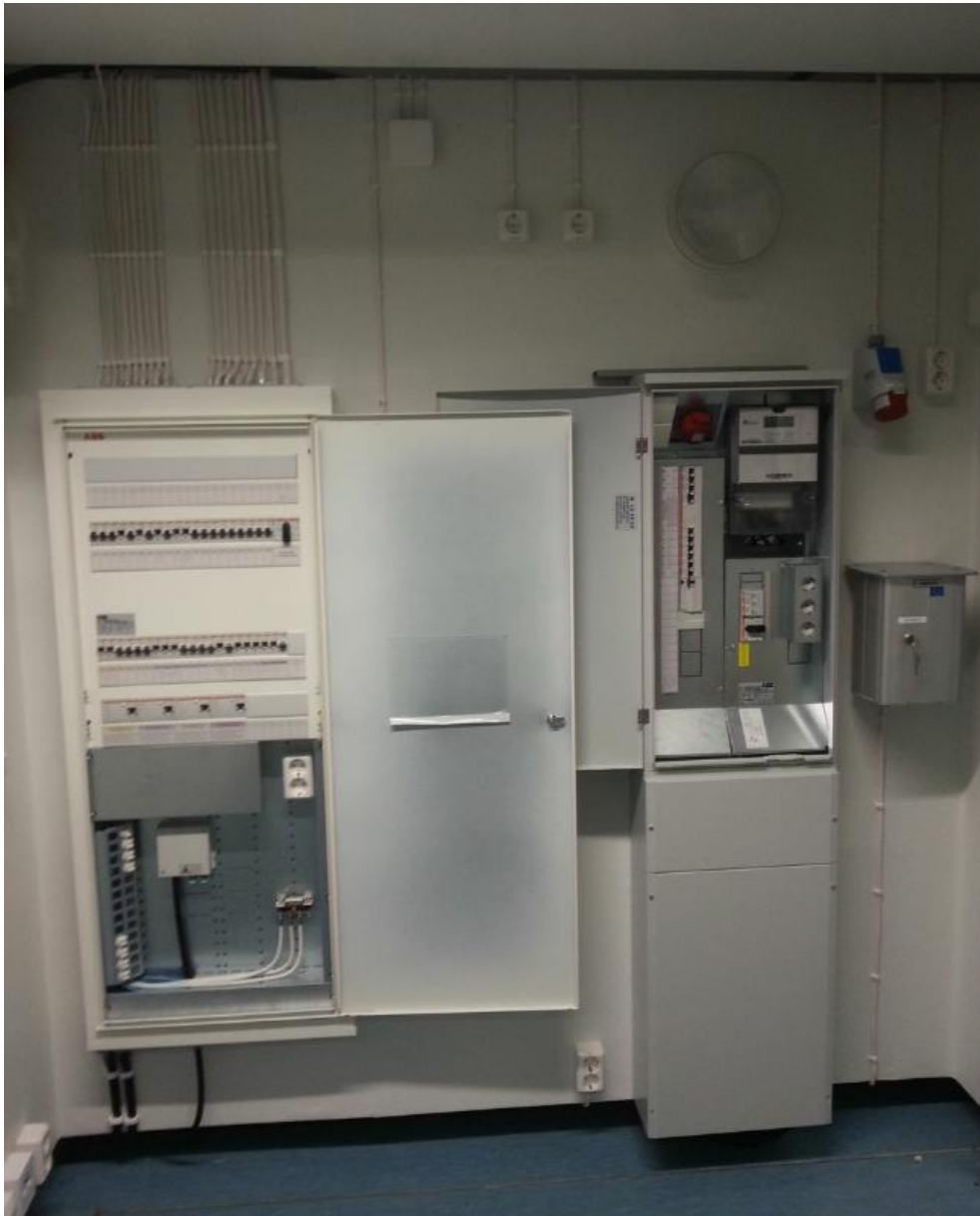
Kuva 41. Kuvassa vasemmalla pääkeskus, keskellä erillinen mittarikeskus, oikealla autolämmitystolppa
