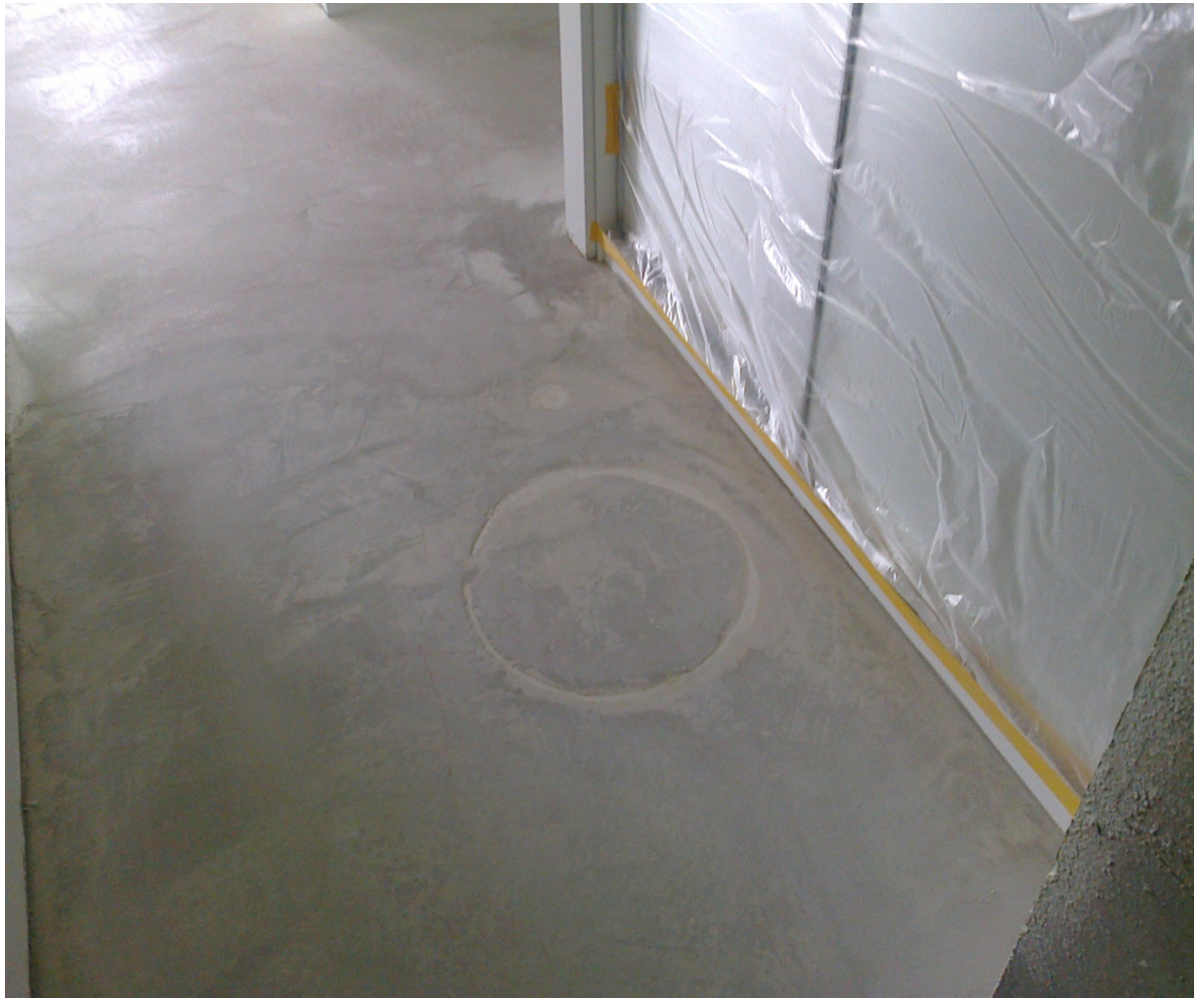
Kuva 2. Kosteusmittauksille varattu paikka tekniikkalaatassa (Kuva Riihijärvi, Heikki 2014)
