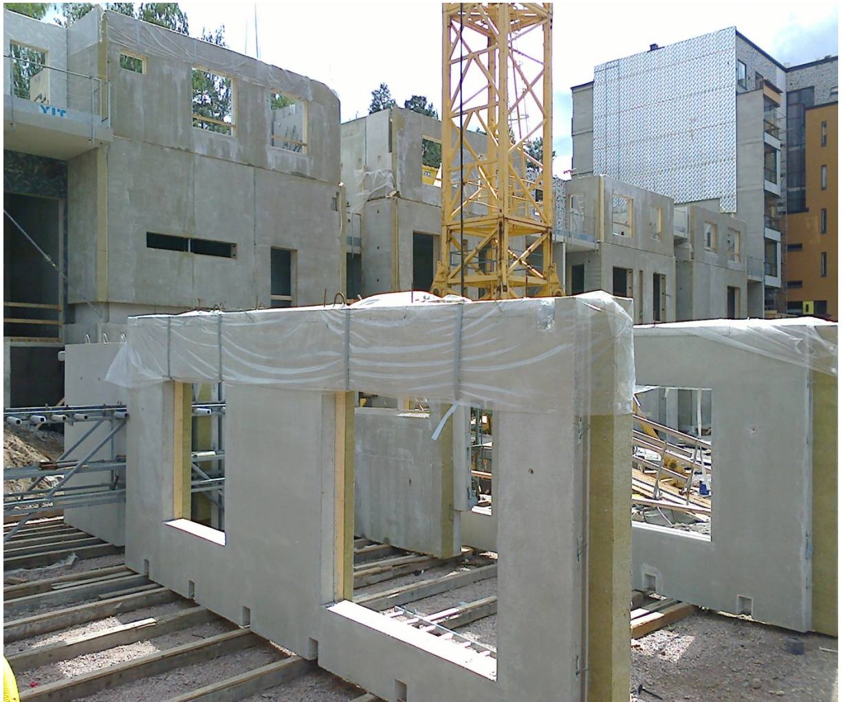
Kuva 6. Elementtien yläosa on suojattu kosteudelta ennen asennusta. (Kuva Riihijärvi, Heikki 2014)
