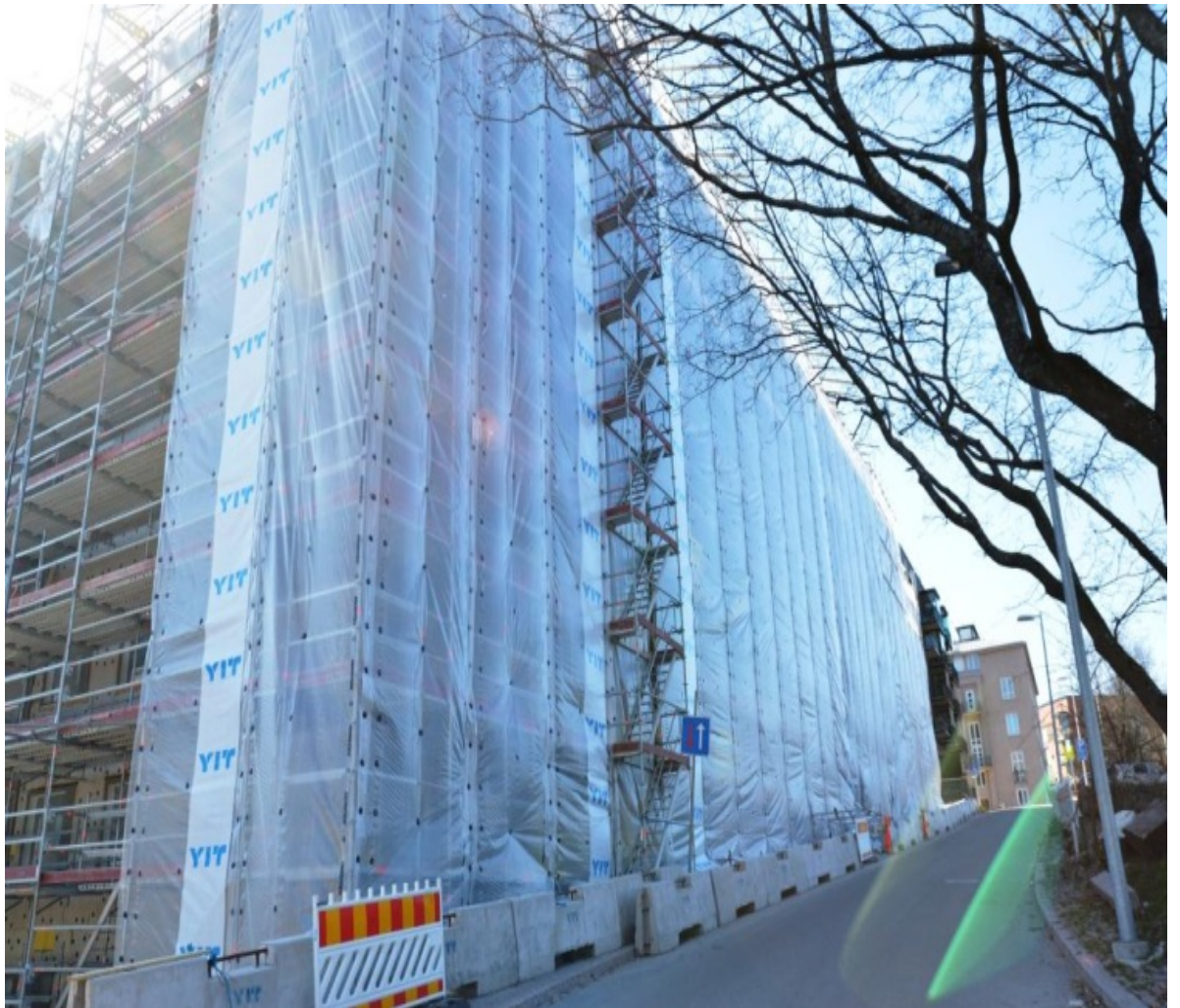
Kuva 7. Julkisivu on sääsuojattu julkisivumuurauksen ajaksi. (Kuva Luoma, Tero 2014)
