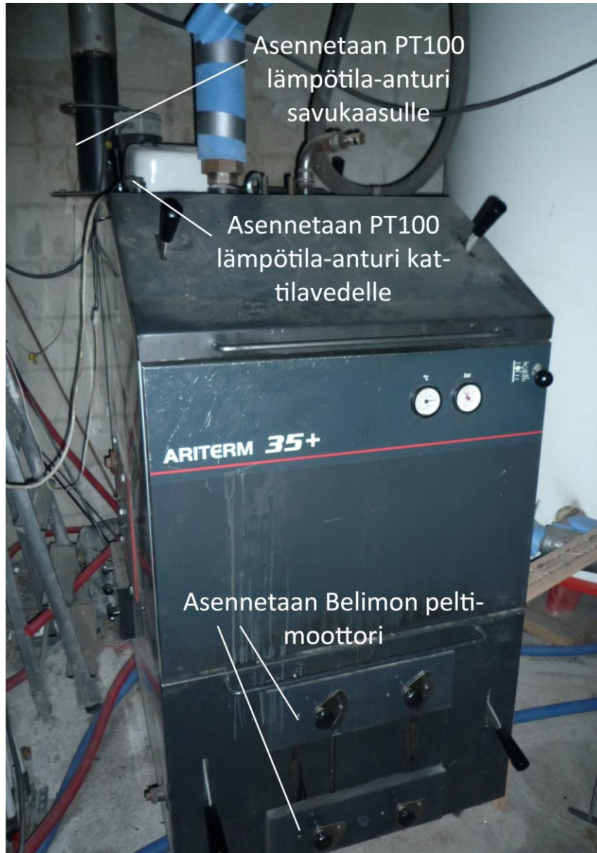
Kuvio 8. PT100-antureiden ja Belimon peltimoottoreiden asennuspaikat
