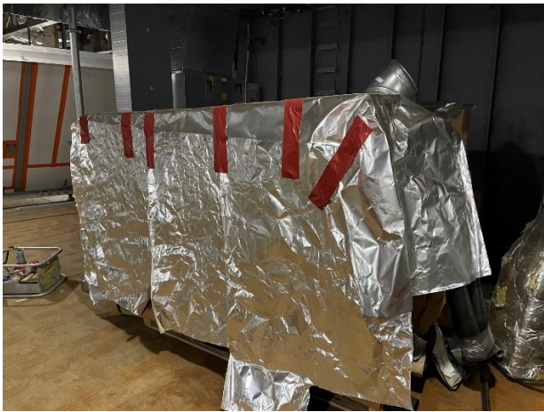
Kuva 12. Suojaus on toteutettu riittävän hyvin
