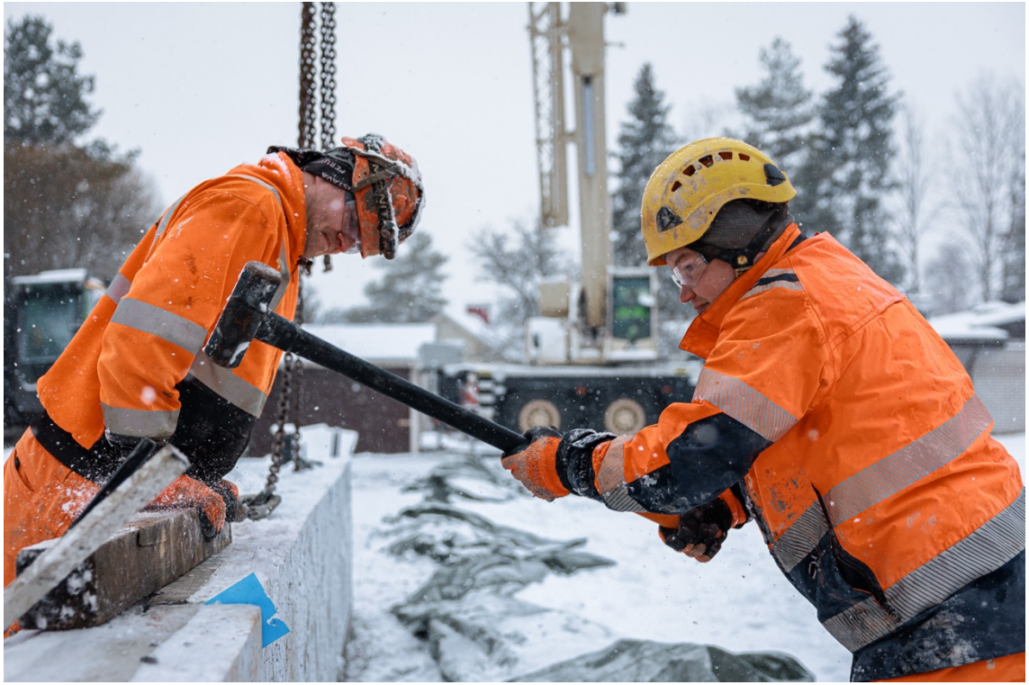
kuva 9. eKiven asennusta. (kuva: Antti Korpi).
