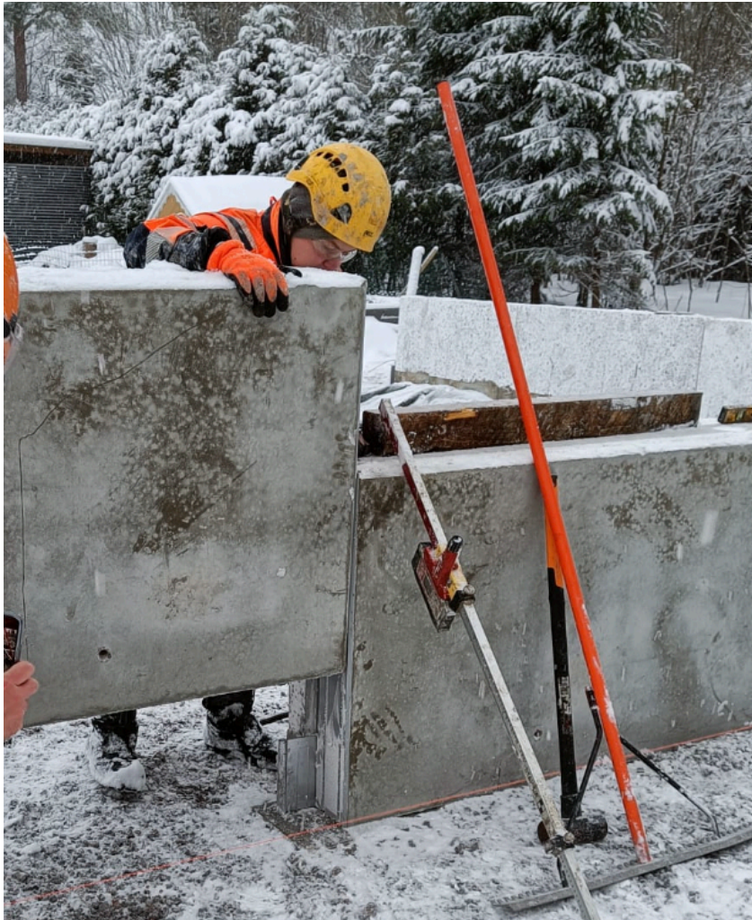
kuva 7. eKivi nostetaan paikalleen. (Kuva: Juho Remes)
