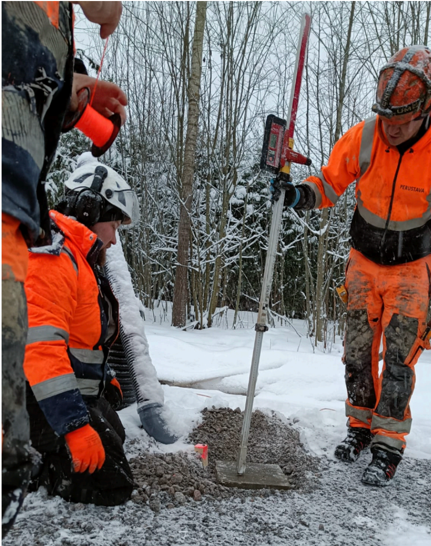
kuva 6. Asennuskiven koron tarkastus. (Kuva: Juho Remes)
