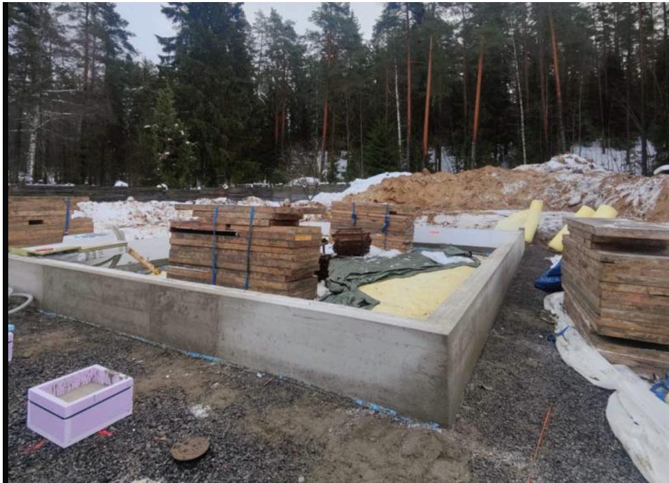
Kuva 5. Muotit purettu. Perustus on valmis. (Kuva: Juho Remes)
