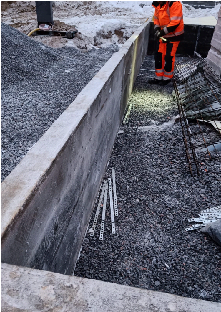
Kuva 4. Ulkokierron muotit pystyssä. (Kuva: Juho Remes)
