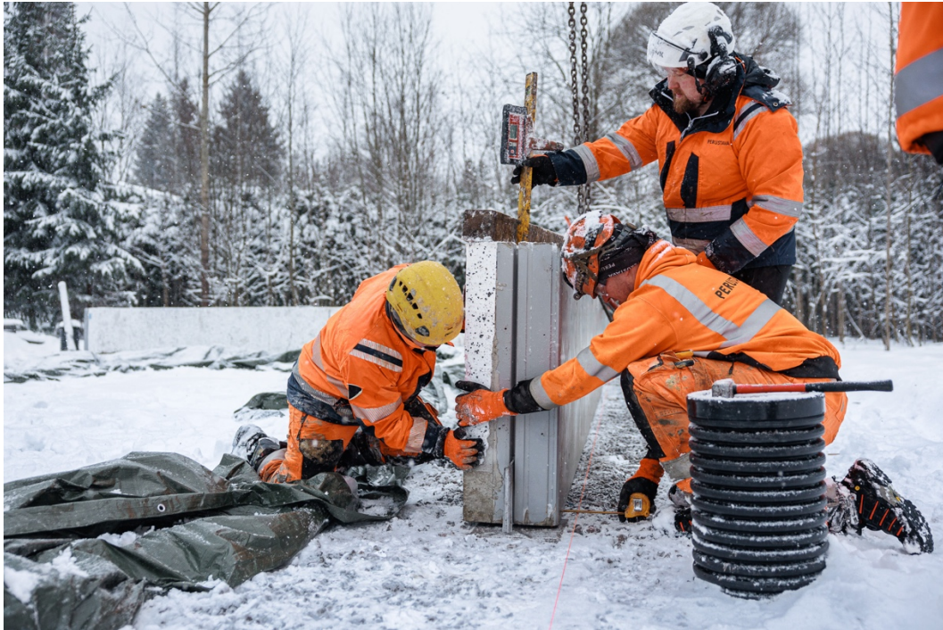
kuva 8. eKiven asennusta.(Kuva: Antti Korpi)
