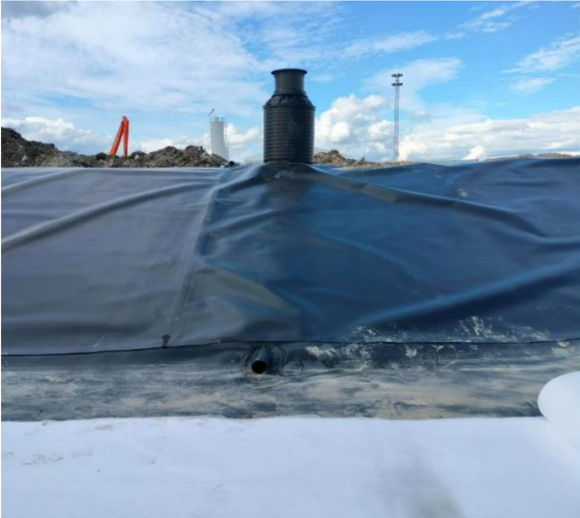
KUVA 12. Salaojaputken läpivienti tiivistyskalvosta kokoojakaivolle
