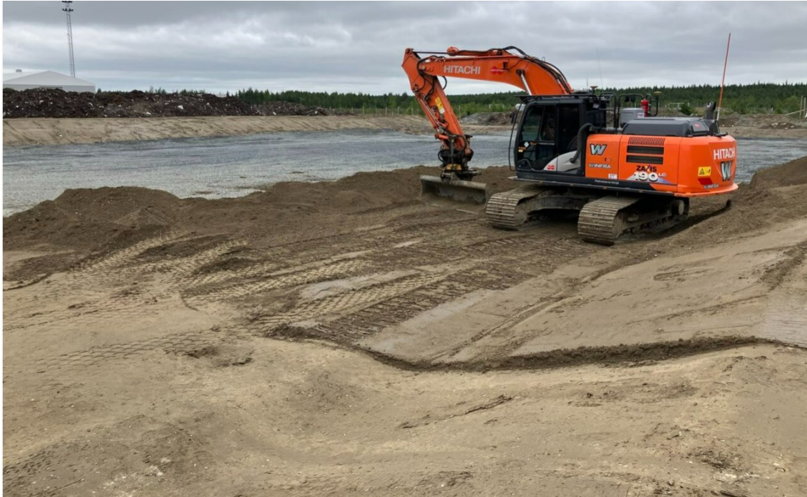
KUVA 9. Koekentän pohjan ja luiskien rakentamista
