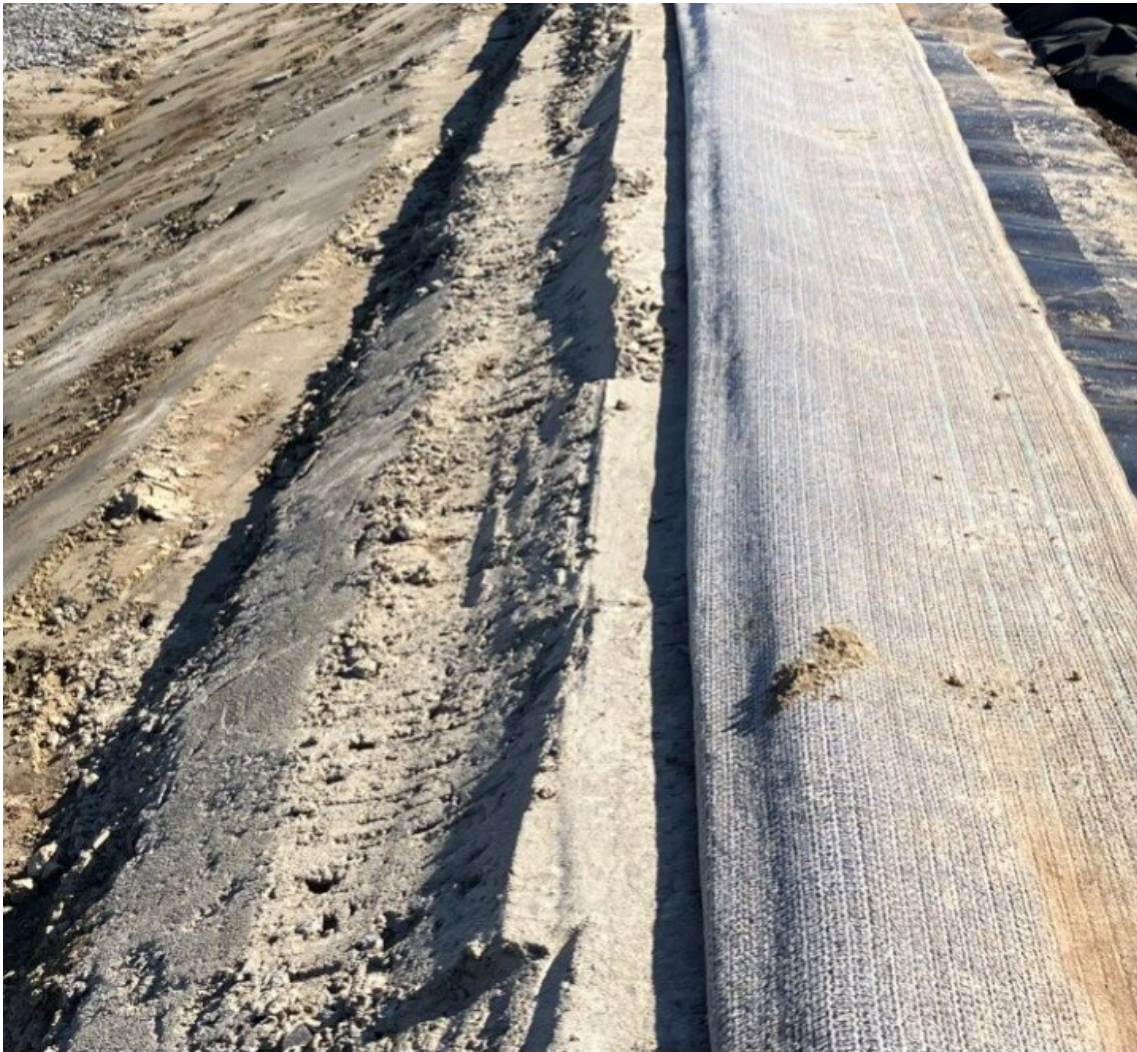
KUVA 7. Työmaakuva porrastuksesta vanhaan rakenteeseen
