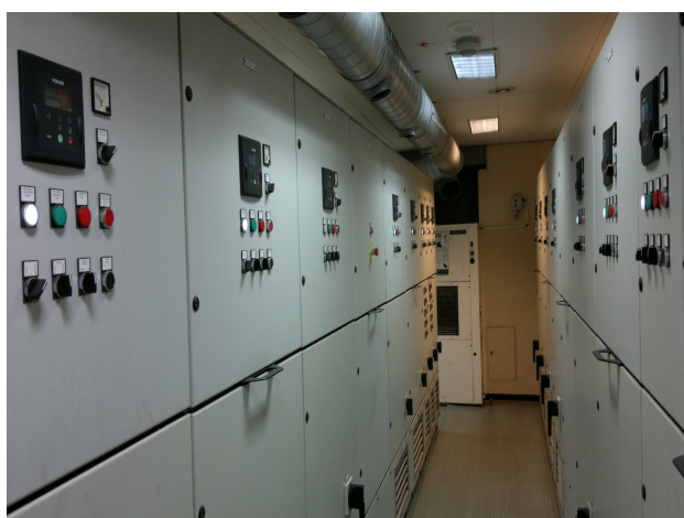
Kuva 10. Lastipumppumoottorinohjauskeskukset CMCC1 ja CMCC2 (Ossi Sjöberg 2014)
