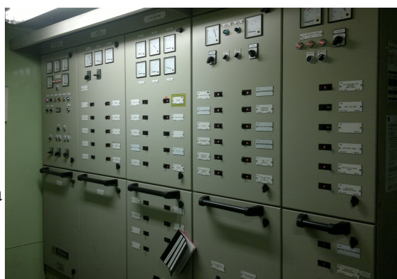
Kuva 9 . Hätätaulut ES1 ja ES2 (Ossi Sjöberg, 2014)
