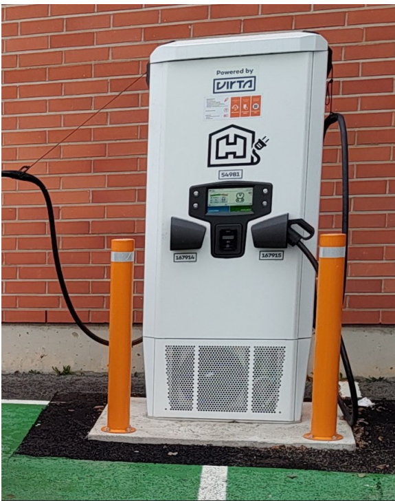
KUVA 4. DC-latausasema Tritium RTM 75
