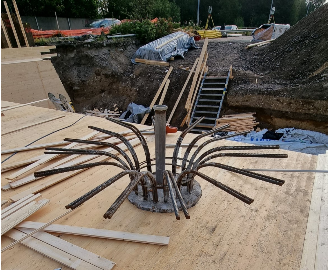
Kuva 4. Paalun yläpää. Teräsputki on täytetty raudoituksella ja sementillä. Tästä muodostuu sillan tukirakenne. Kuvassa näkyy, kuinka sillan muotti on rakennettu pilarin ympärille.
