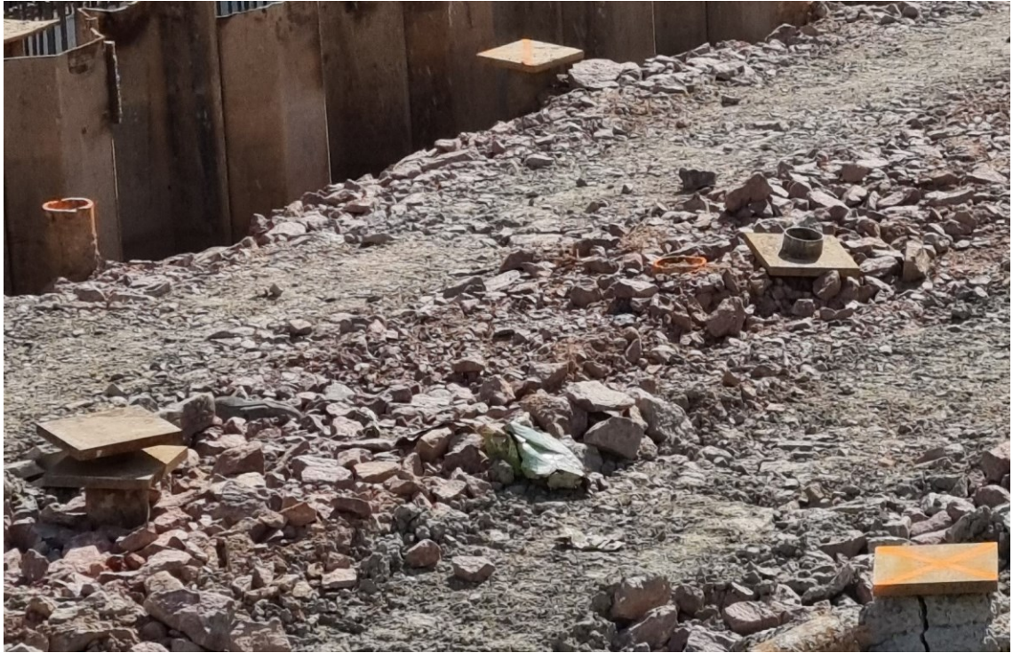
Kuva 23. Mitattuja pienpaaluja. Kuvan oikeassa laidassa näkyy kallistunut paaluhattu.
