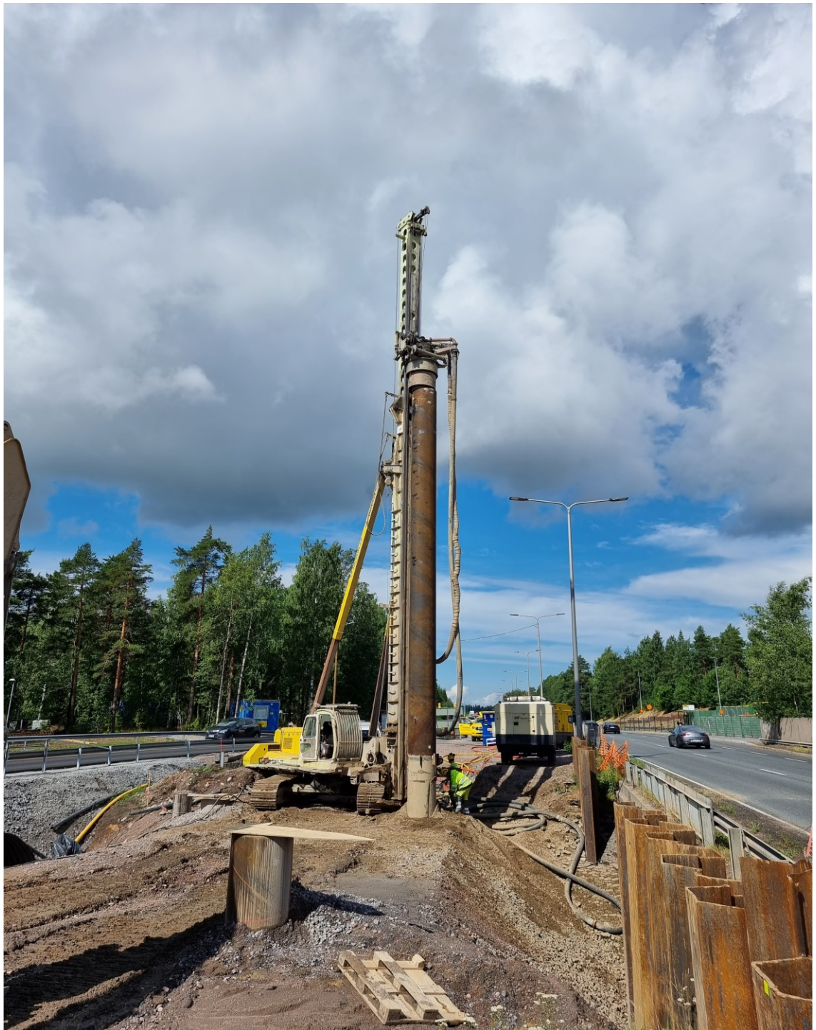
Kuva 3. Kurkimäen alikulkukäytävien sillan pilareiden paalutustyö käynnissä. Hitsaaja liittää jatkokappaletta kiinni.
