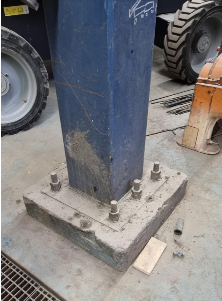
KUVA 10. Kattilapilarin kiinnityminen perustuksiin (5)
