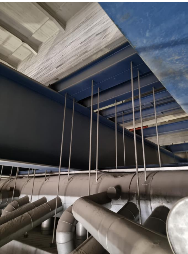
KUVA 8. Ripustintankojen kiinnittyminen tertiäripalkkeihin (5)
