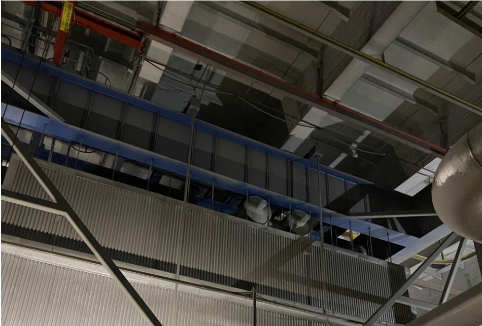
KUVA 7. K7-kattilan ripustustangot (5)
