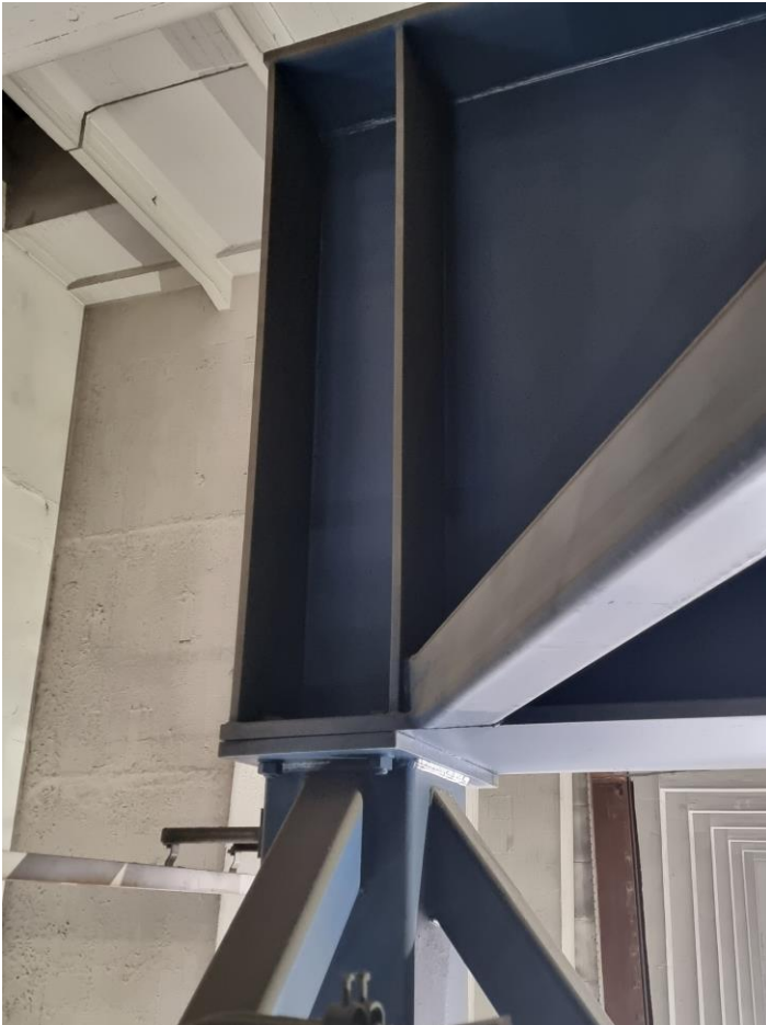
KUVA 11. Kattilapilarin ja Kattilapalkin välinen liitos (5)
