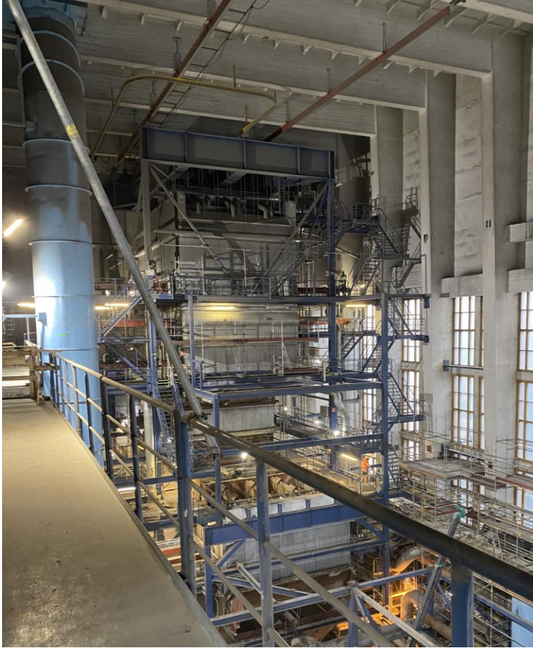
KUVA 2. K7-kattila purkutöiden aikana 10.1.2024 (5)
