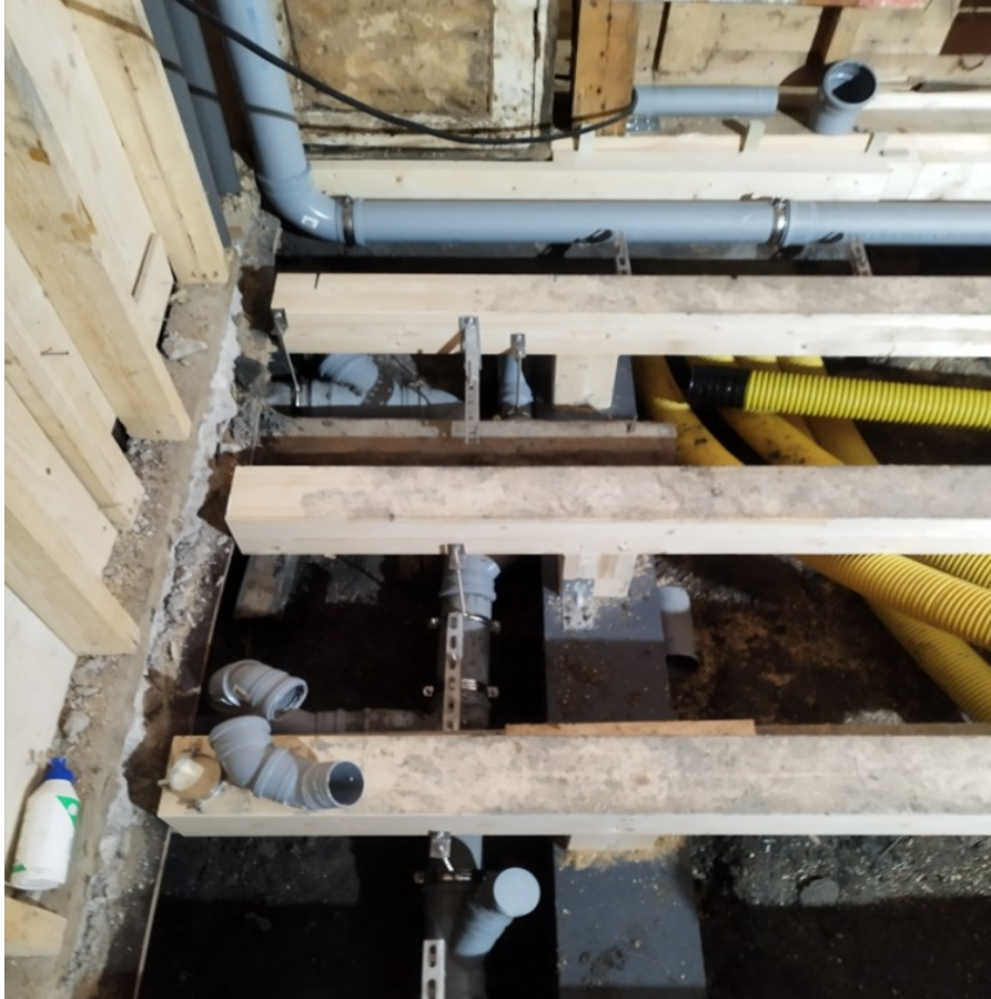
Kuva 9. Betonisen laatan alapuolinen osa sosiaalitilojen alla.
