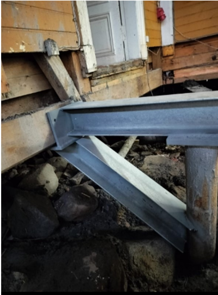
Kuva 11. HEA-palkin liitos seinärakenteeseen.
