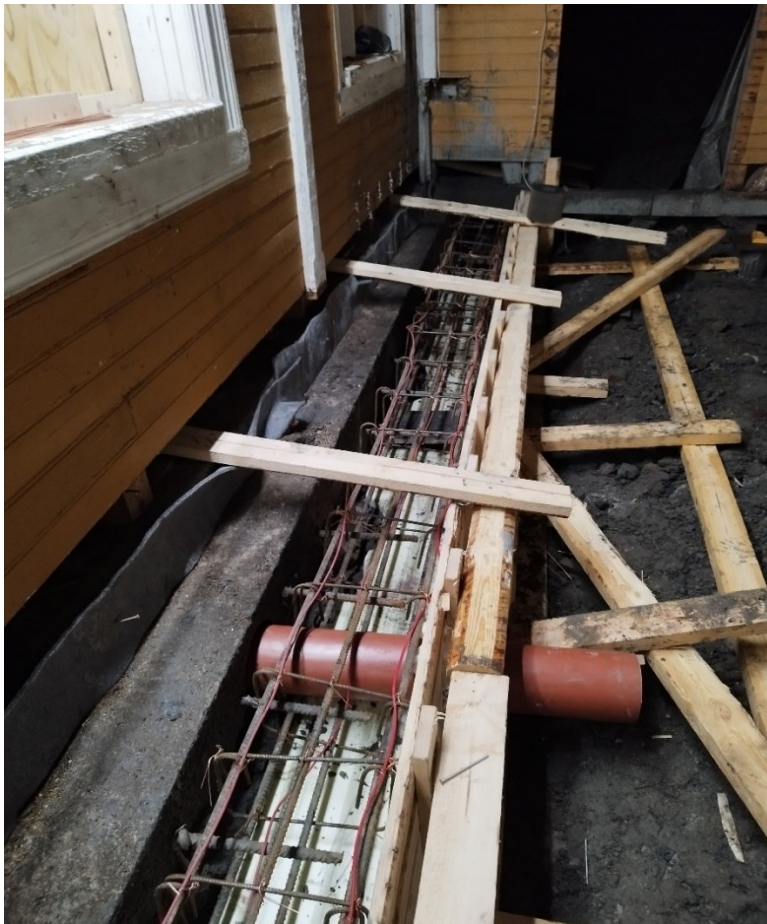
Kuva 6. Vahvistusantura vanhan anturan viereen.
