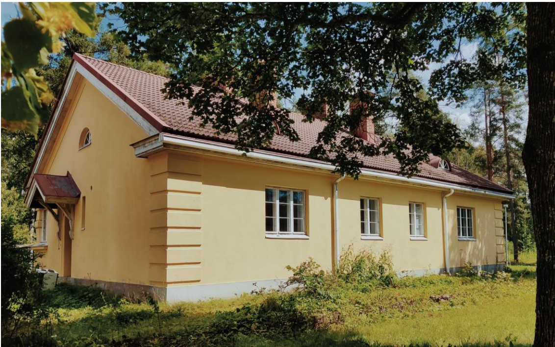
KUVA 4. Valokuva Oikosulku 18:n julkisivujen yksityiskohdista 17.7.2023
