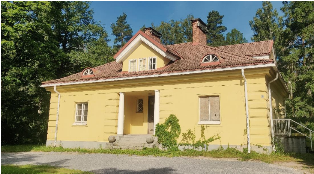
KUVA 5. Valokuva Ekegreninraitti 3:n pääsisäänkäynnistä 12.7.2023
