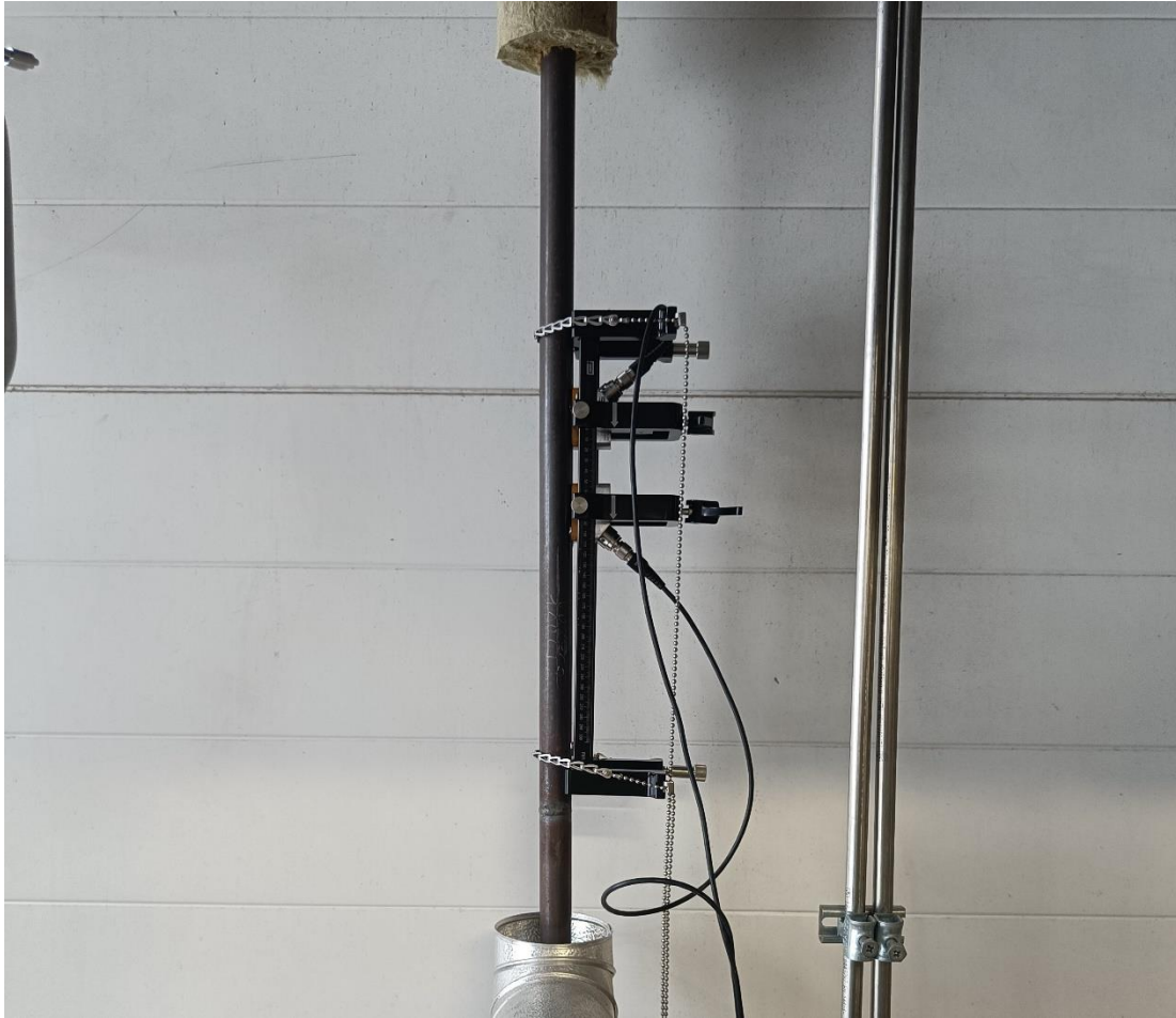
Kuva 11. JUP-säiliöstä tulevan kuorittu lämmitysputken mittauspiste.
