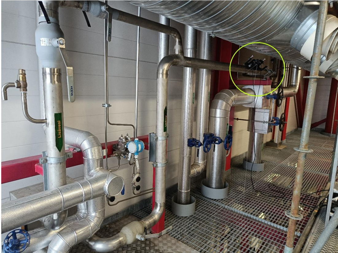
Kuva 8. mittauspiste sijaitsee lisävesiputkilinjan puolella välissä.
