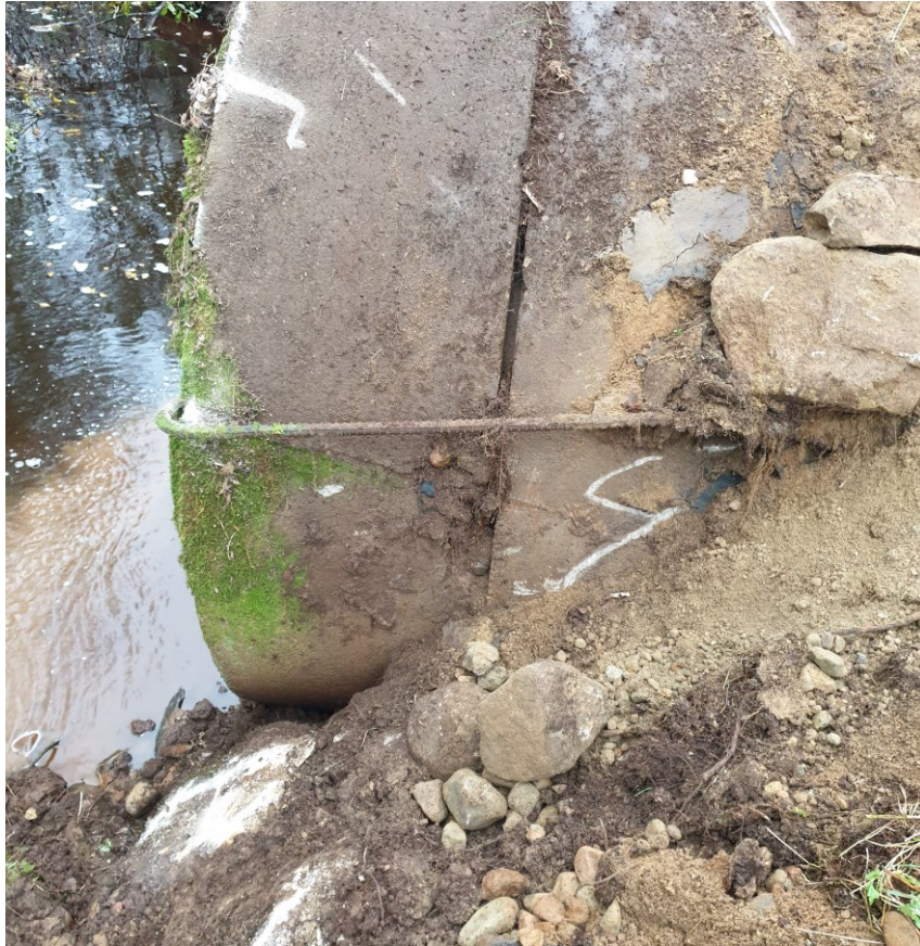
KUVA 15. Rumpujen siderautojen kunnon tarkistus
