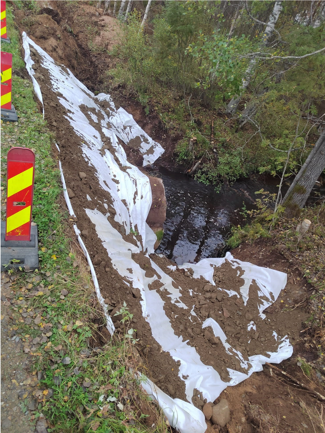
KUVA 16. Suodatinkangas levitetty rummun ympärille
