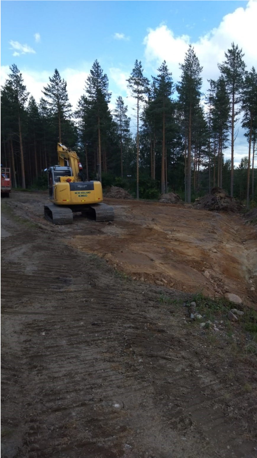
KUVA 8. Tien päähän tulevan käänköpaikan pintamaiden poisto ja pohjien muotoilu
