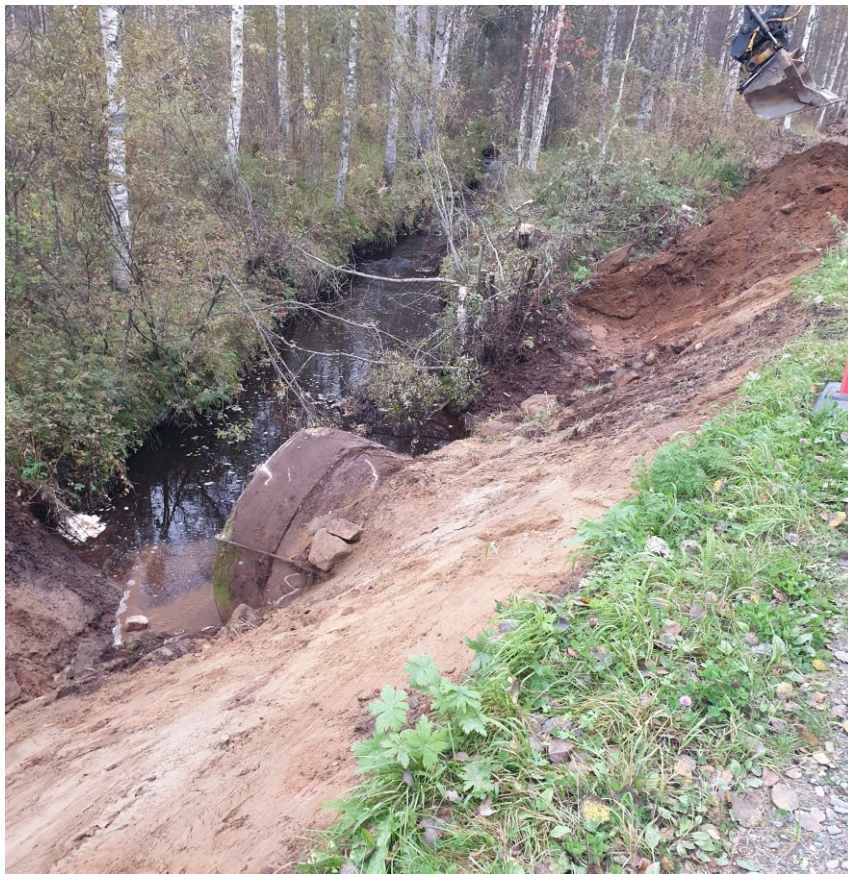
KUVA 14. Kohteesta poistettu pintamaat ja rummun päät kaivettu esiin
