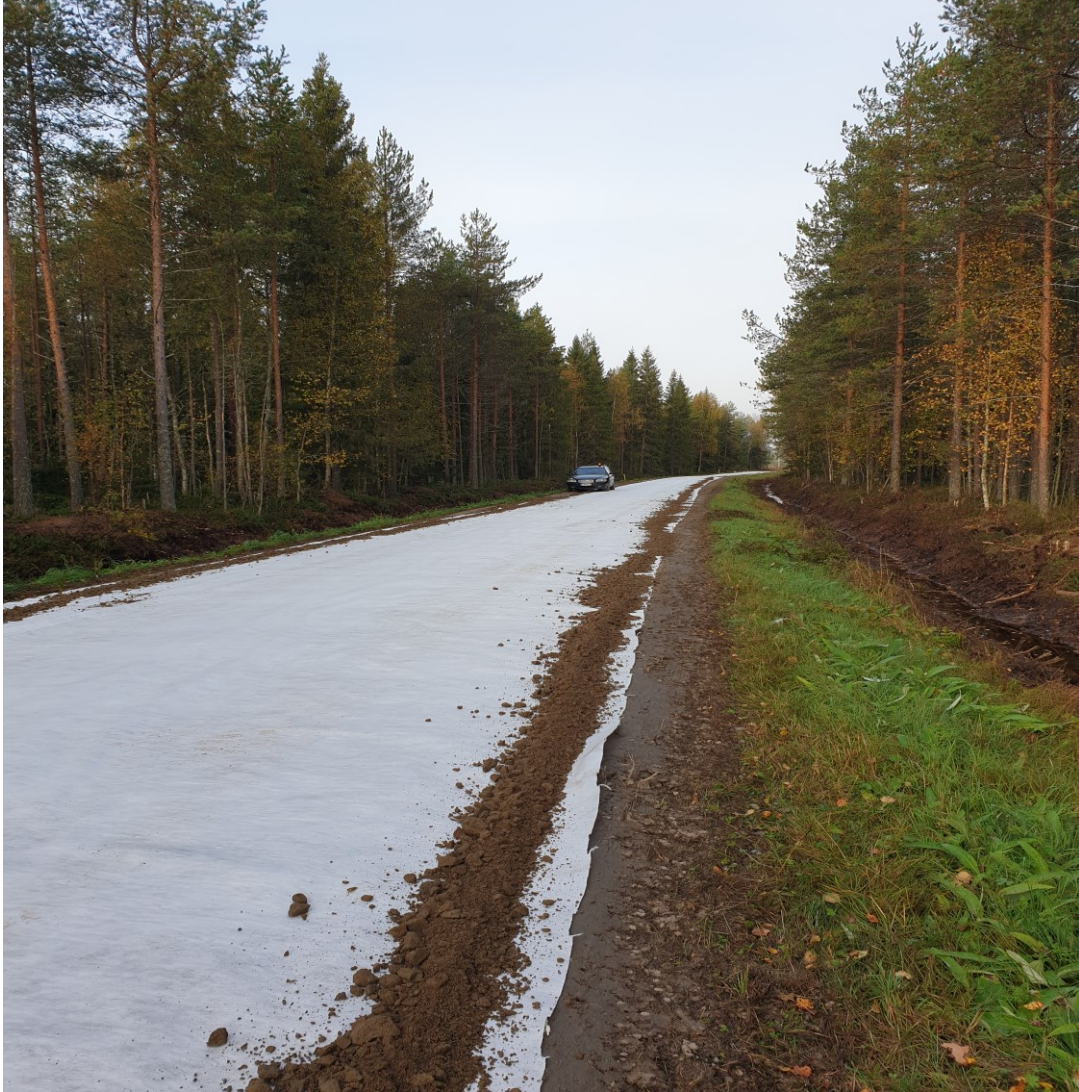
KUVA 10. Suodatinkangas levitettynä vanhalle tienpinnalle
