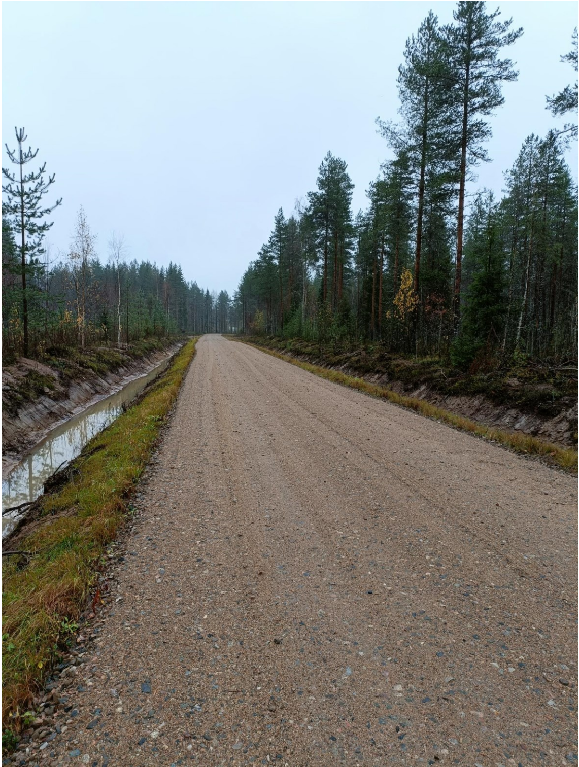
KUVA 12. Kulutuskerros ajettu, muotoiltu ja tiivistetty
