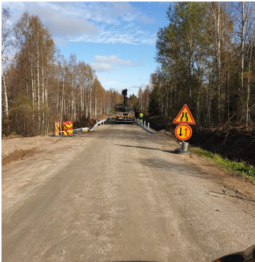
KUVA 18. Uusien kaiteiden asennus
