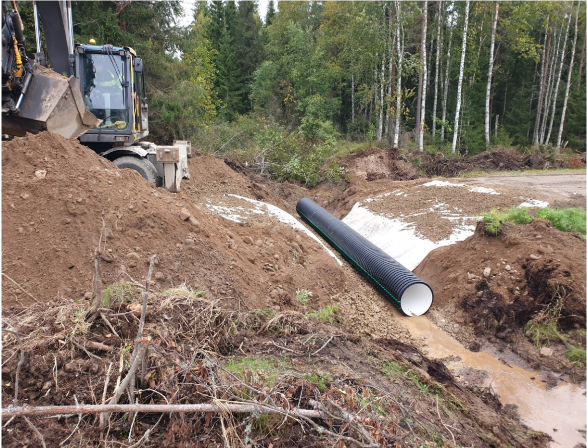
KUVA 4. Suodatinkangas ja uusi rumpu asetettu kaivantoon
