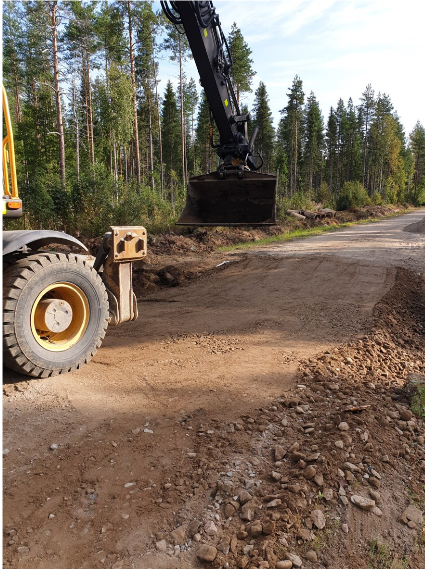
KUVA 5. Kaivanto täytetty ja tiivistetty
