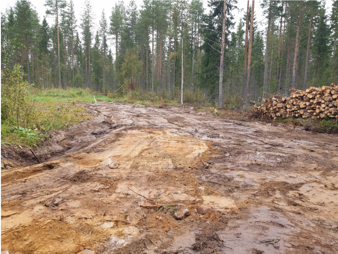
KUVA 7. Risteykseen tulevan kääntöpaikan muotoiltu pohja
