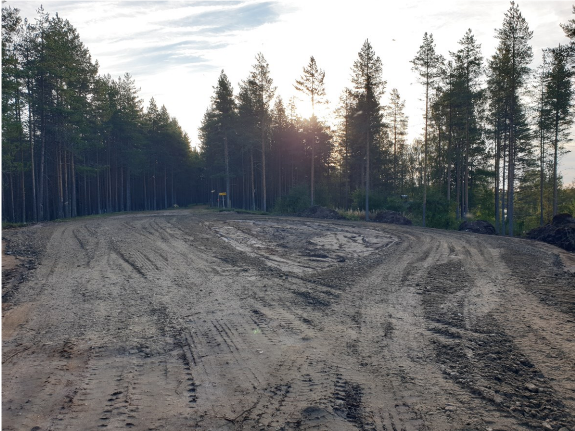
KUVA 9. Tien päähän tulevan käänköpaikan murskeet ajettu ja valmiina tiivistettäväksi
