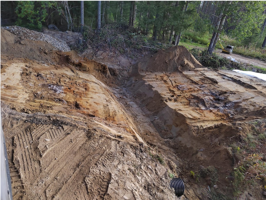
KUVA 3. Vanha päätierumpu poistettu ja uudelle rummulle valmis kaivanto
