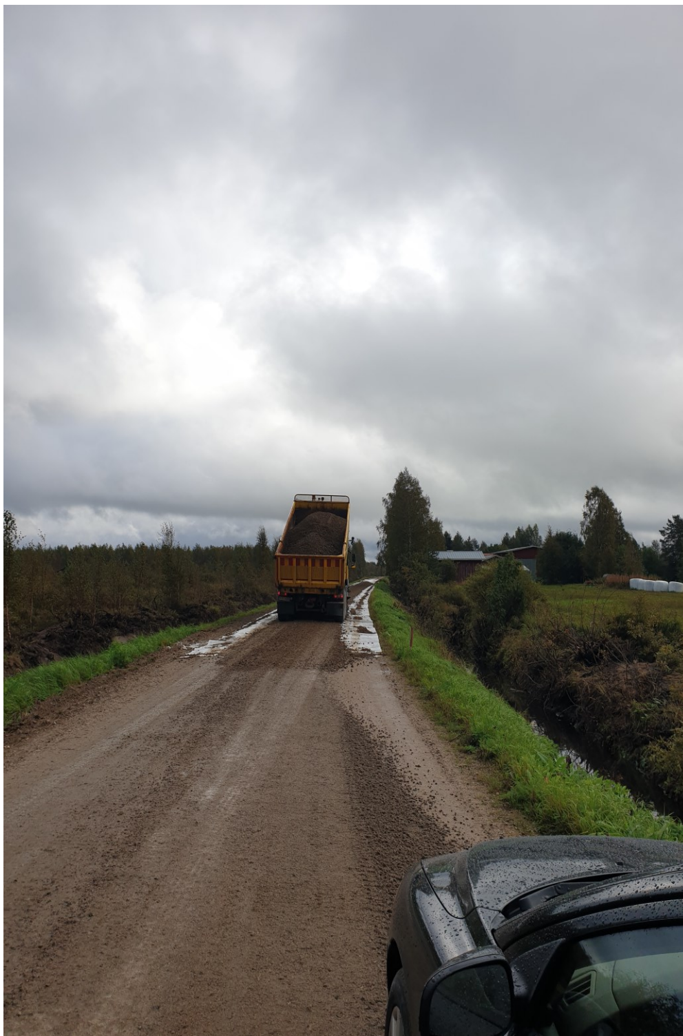
KUVA 11. Kantavan kerroksen murskeen ajo suodatinkankaan päälle
