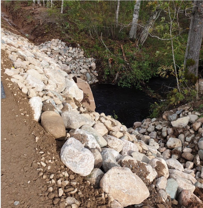
KUVA 17. Kiviheitoke asennettu suodatinkankaan päälle
