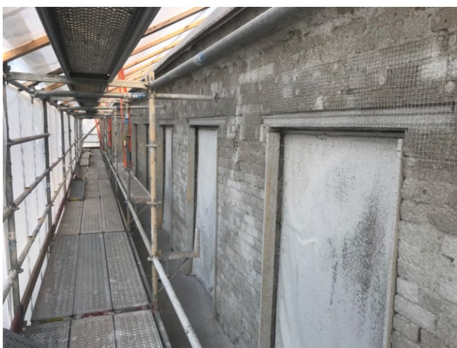
Kuva 20. Verkotettua ja tartuntarappattu seinä.
