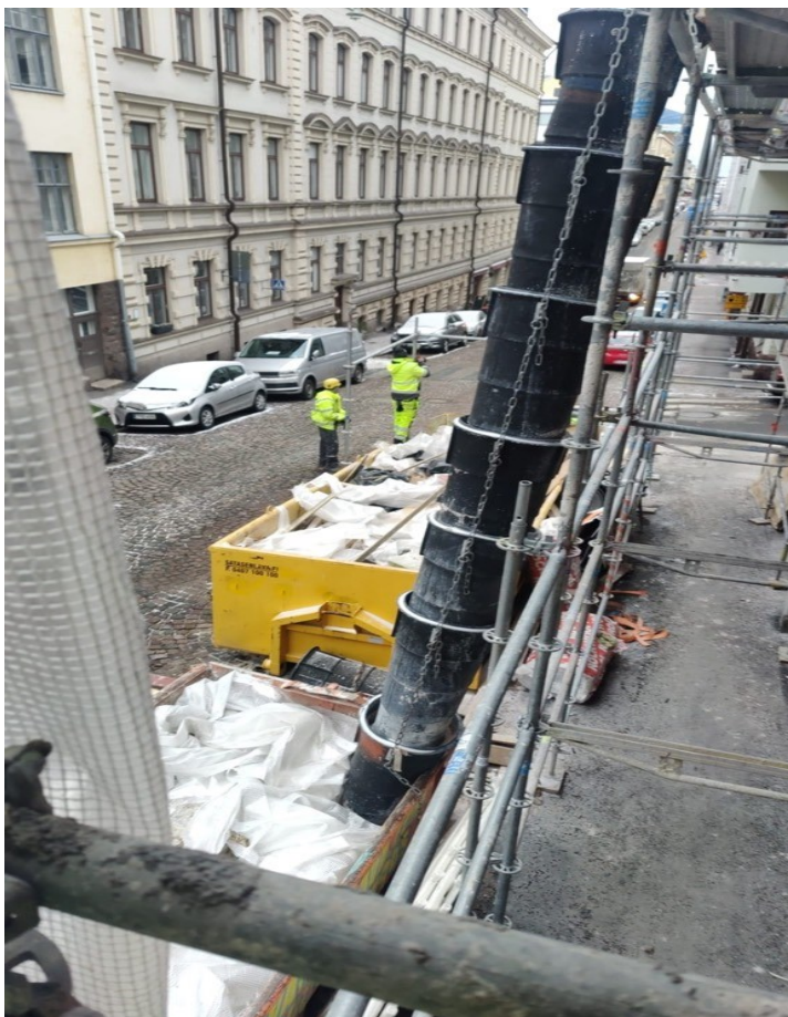
Kuva 10. Pudotusputket asennettuna telineisiin ja kohdistettu kivilavaan.
