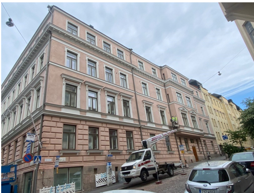
Kuva 30. Nostimelta tehtävät seinän viimeistelytyöt käynnissä.
