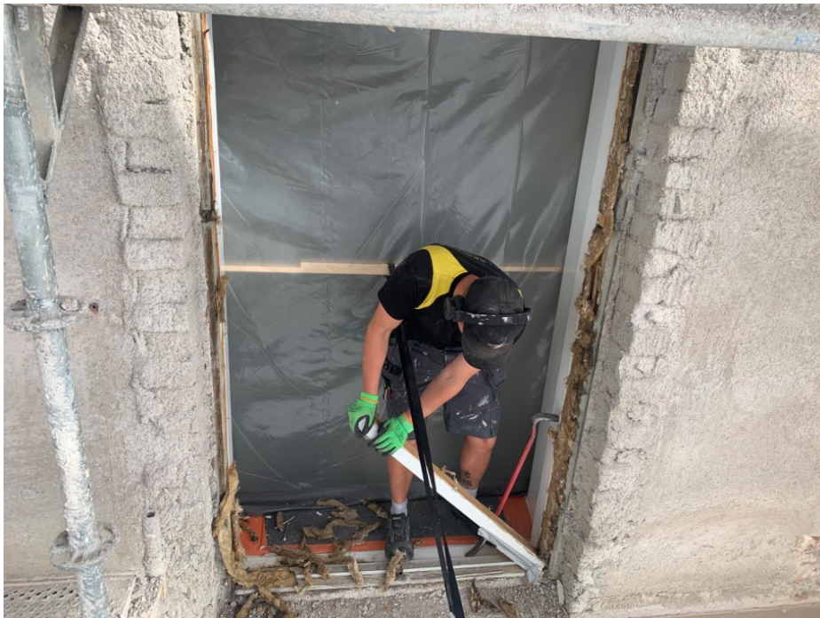
Kuva 14. Ikkunoiden purkutyöt käynnissä.
