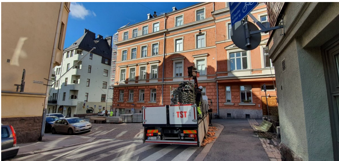
Kuva 3. Telineateriaalit tuodaan työmaalle.
