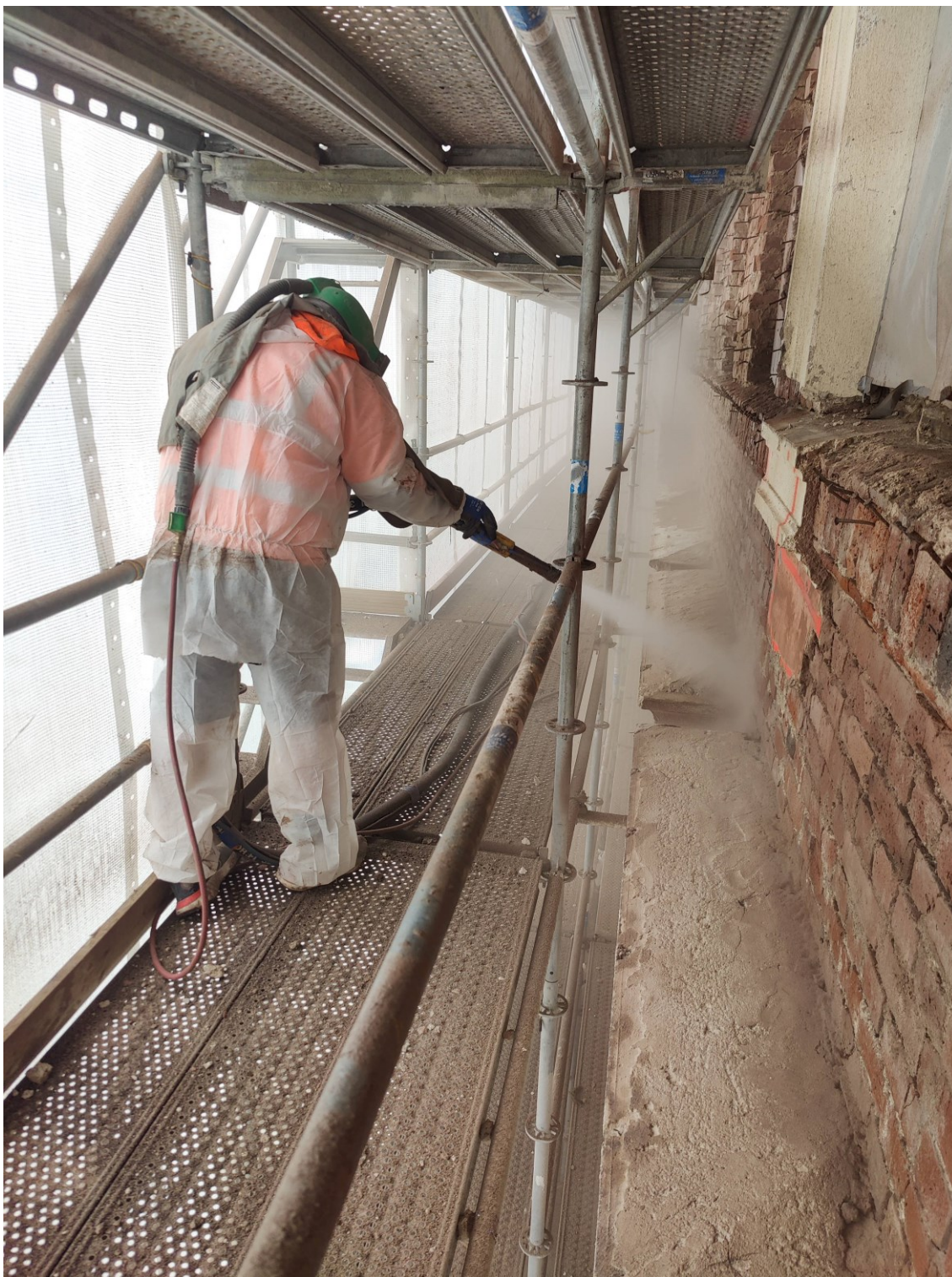
Kuva 12. Seinän hiekkapuhallus käynnissä.
