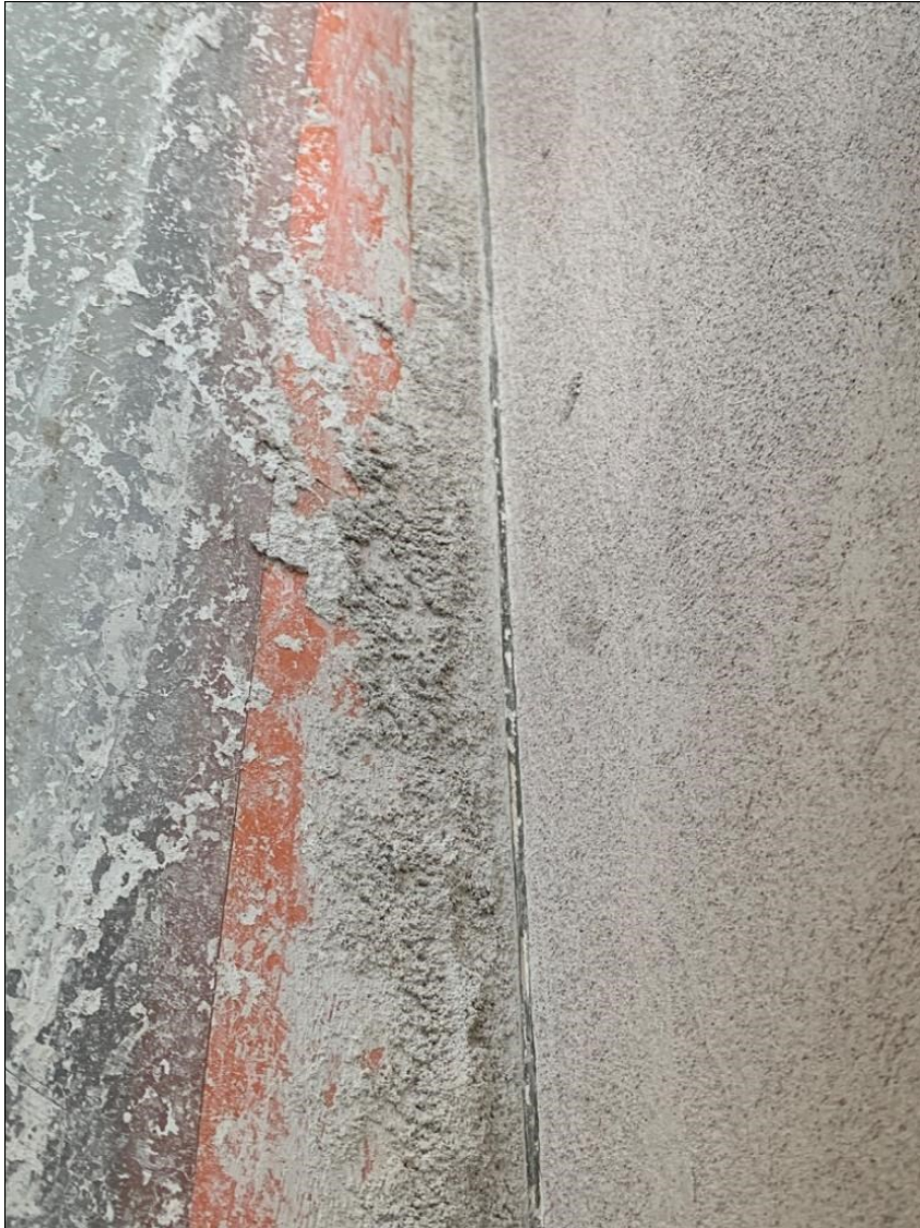
Kuva 24. Rajapinnat käyty läpi.
