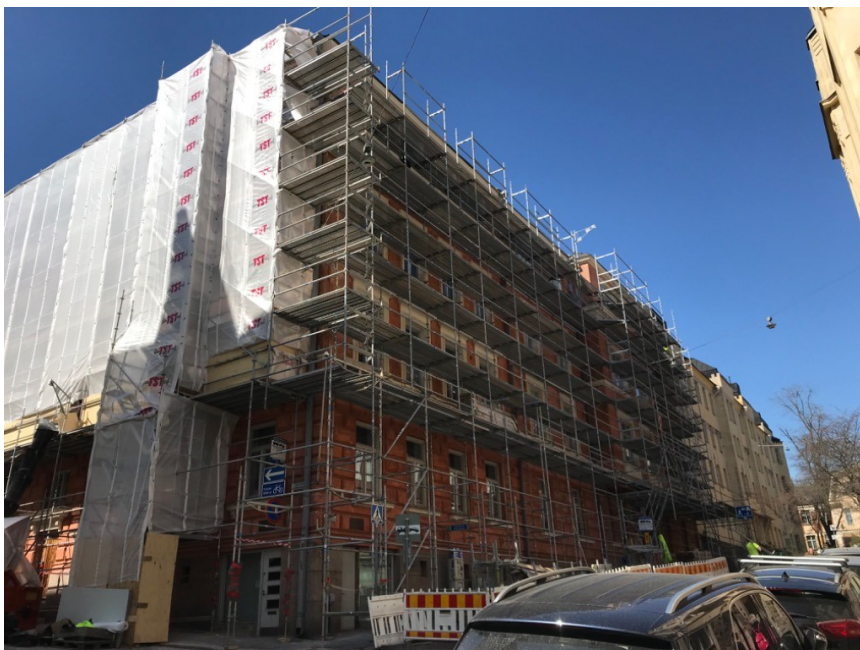
Kuva 7. toisen sivun telineiden runkotyöt valmiina.
