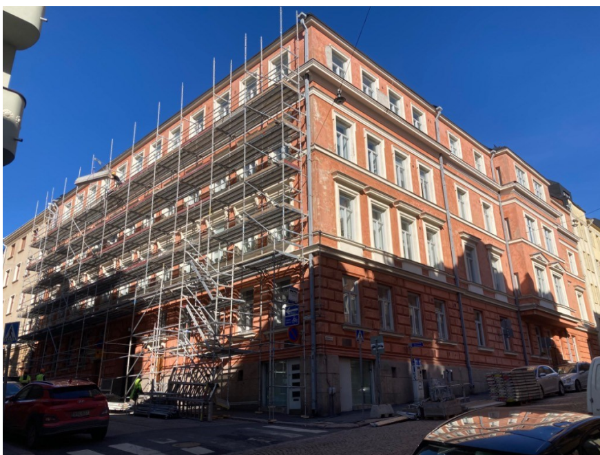
Kuva 4. Toisen sivun telineiden runkoa kasattuna.
