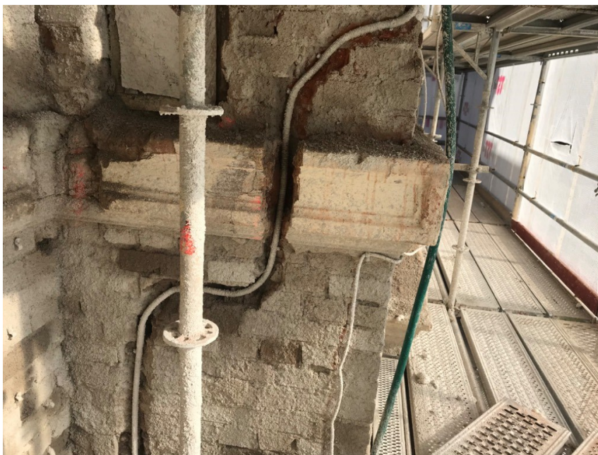
Kuva 19. Sähköroilot upotettuna seinää.
