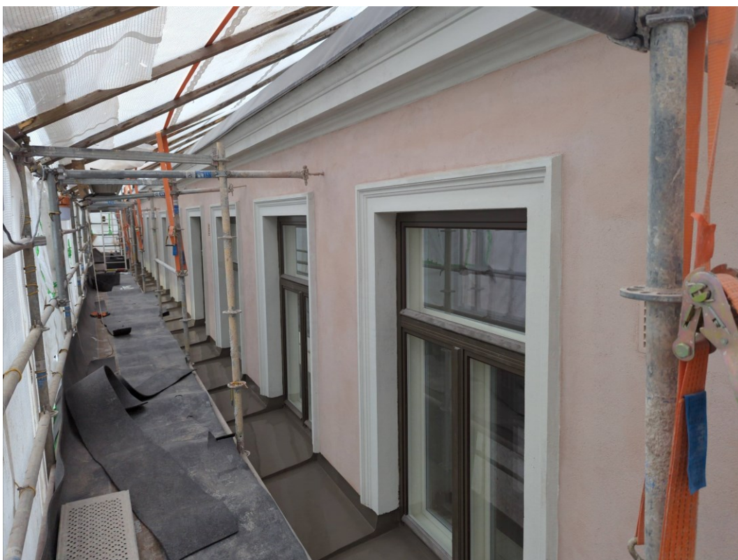
Kuva 28. Kaikki maalaustyöt tehtynä.
