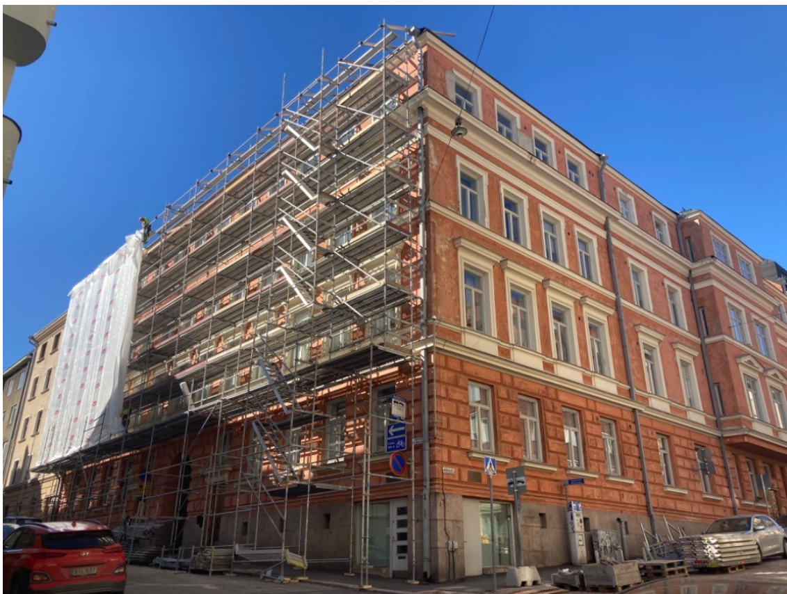
Kuva 5. Toisen sivun telineiden sääsuojan asennus käynnissä.
