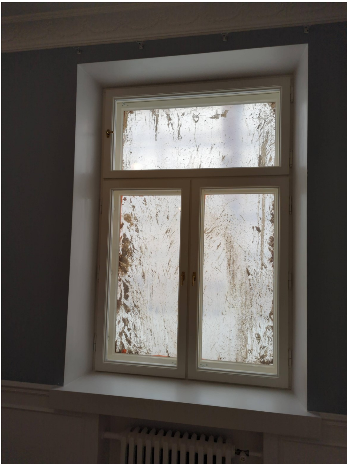
Kuva 16. Uusiasennettu ikkuna sisältäpäin kuvattuna. Ulkoapäin suojattu.
