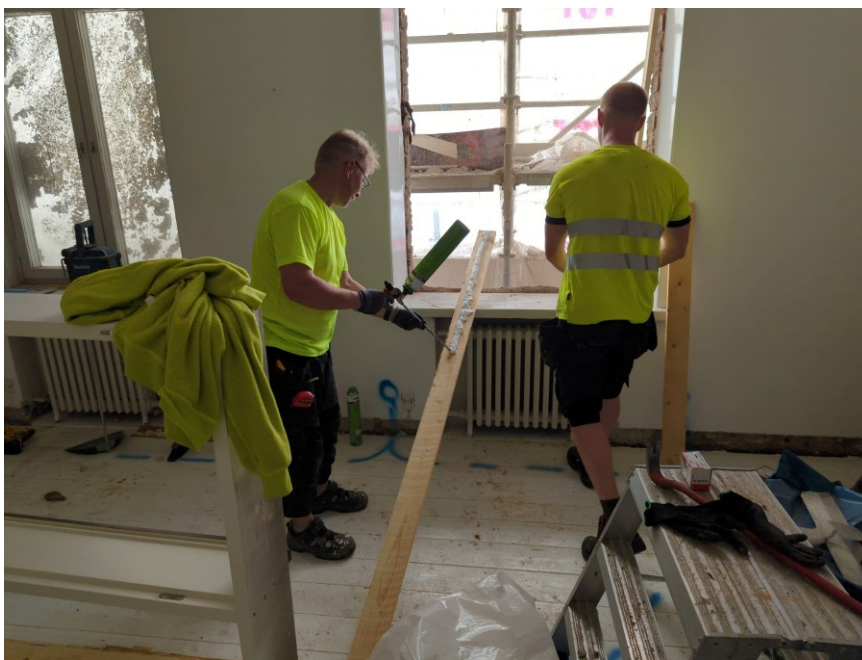
Kuva 15. Asentajat eristämässä tilkerakoa.
