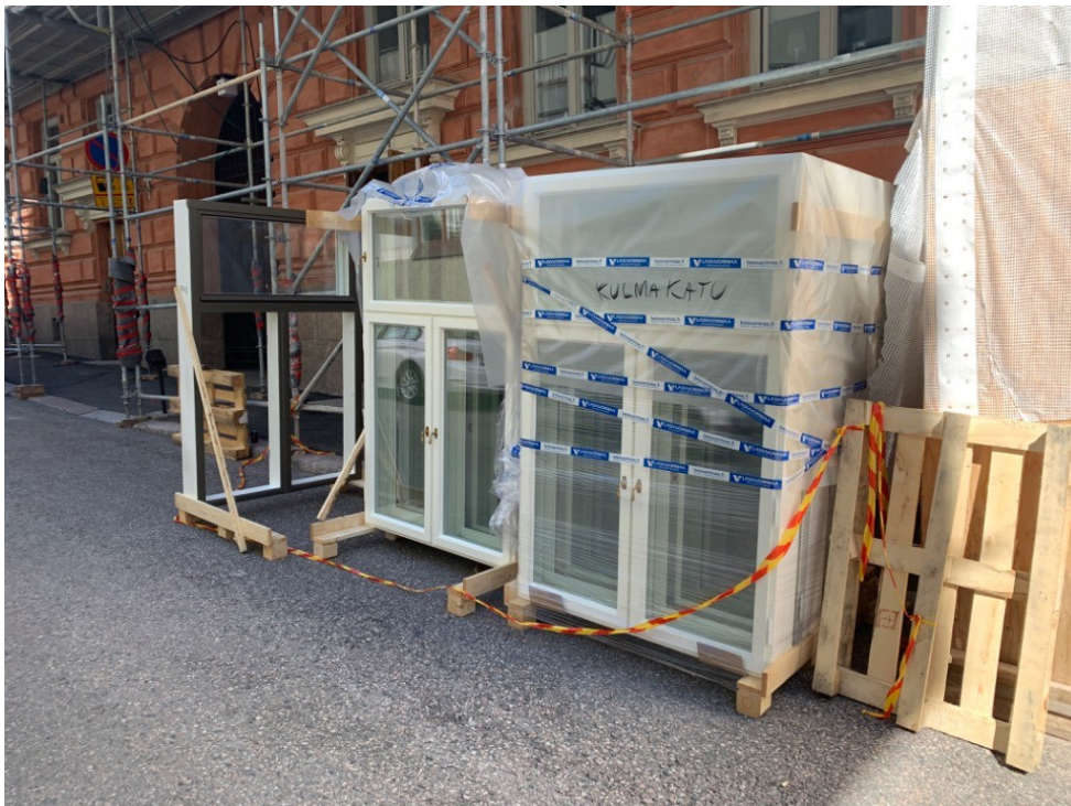
Kuva 13. Ikkunat työmaalla varatulla katualueella.
