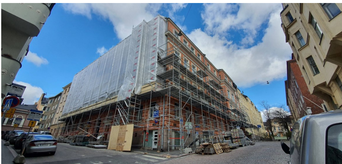
Kuva 6. Toisen sivun telineiden sääsuojan asennus valmiina ja toisen sivun telineiden runkotyöt käynnissä.
