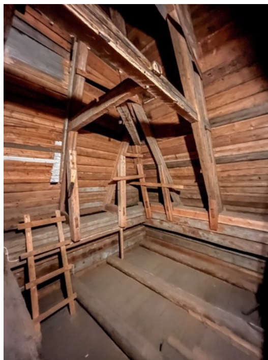
KUVA 148. Vesikatossa nähtävissä aiemmin siinä olleiden kattolyhtyjen paikat (Kuva: Viivi Koski 2024).
