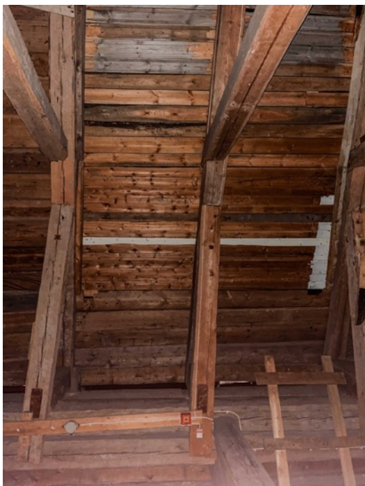
KUVA 148. Vesikatossa nähtävissä aiemmin siinä olleiden kattolyhtyjen paikat (Kuva: Viivi Koski 2024).
