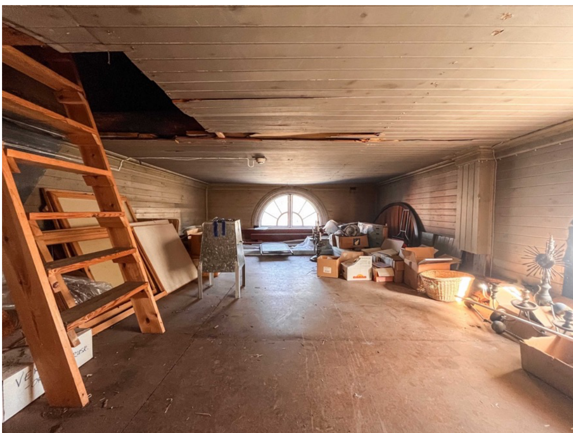
KUVA 143. Sakariston päällinen ullakotila, johon alempien huoneiden ikkunat yltävät (Kuva: Viivi Koski 2024).
