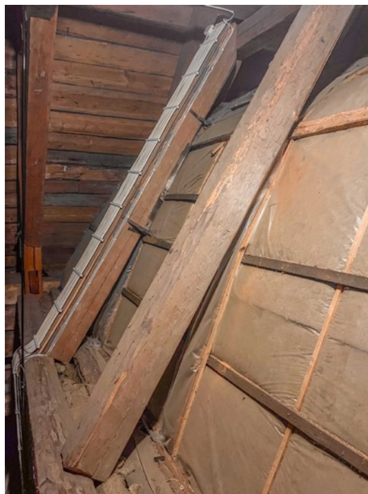
KUVA 146. Kirkon yläpohjan tuulettuva huoltotila (Kuva: Viivi Koski 2024).
