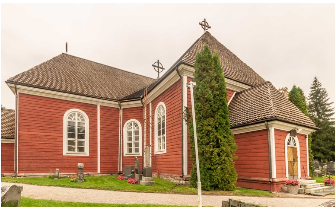
KUVA 55. Kirkon eteläsivu 2023 (Kuva: Viivi Koski 2023).
