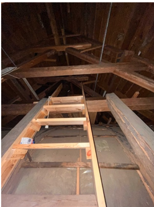
KUVA 146. Kirkon yläpohjan tuulettuva huoltotila (Kuva: Viivi Koski 2024).
