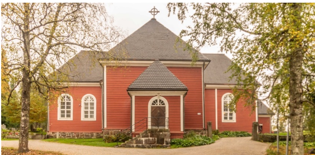
KUVA 98. Julkisivu pohjoiseen tielle (Kuva: Viivi Koski 2023).
