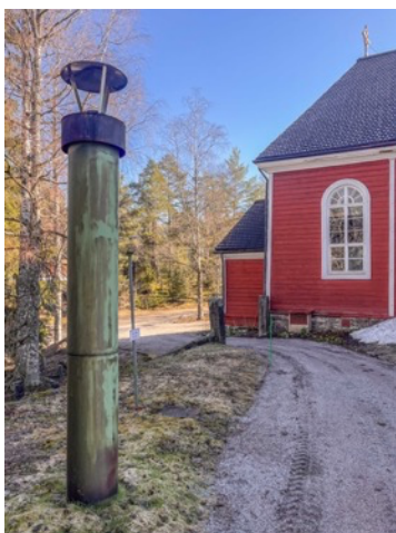
KUVA 110. Pannuhuoneen ilmanvaihtoputki (Kuva: Viivi Koski 2024).
