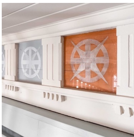
KUVA 42. Kuvassa oranssinsävyinen restauroitu ornamenttikuvio eteläparven ulkoseinällä (Kuva: Viivi Koski 2024).
