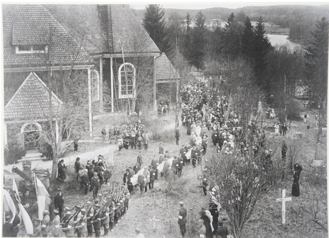
KUVA 52. Kirkon julkisivu ja piha-alueita tapulista kuvattuna 1918. (Museovirasto.)
