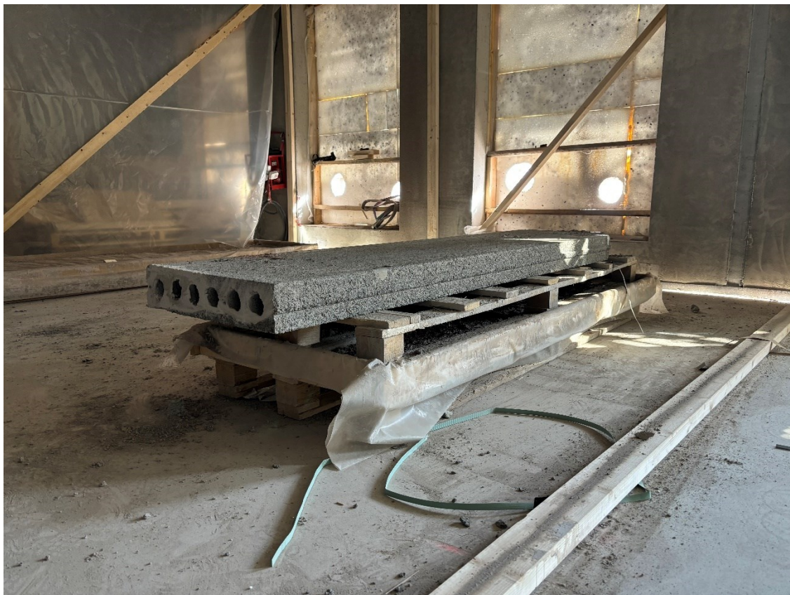
KUVA 13. Sahaalusta, jonka päällä AKOwall-elementti (Mäkikoivu 2024).
