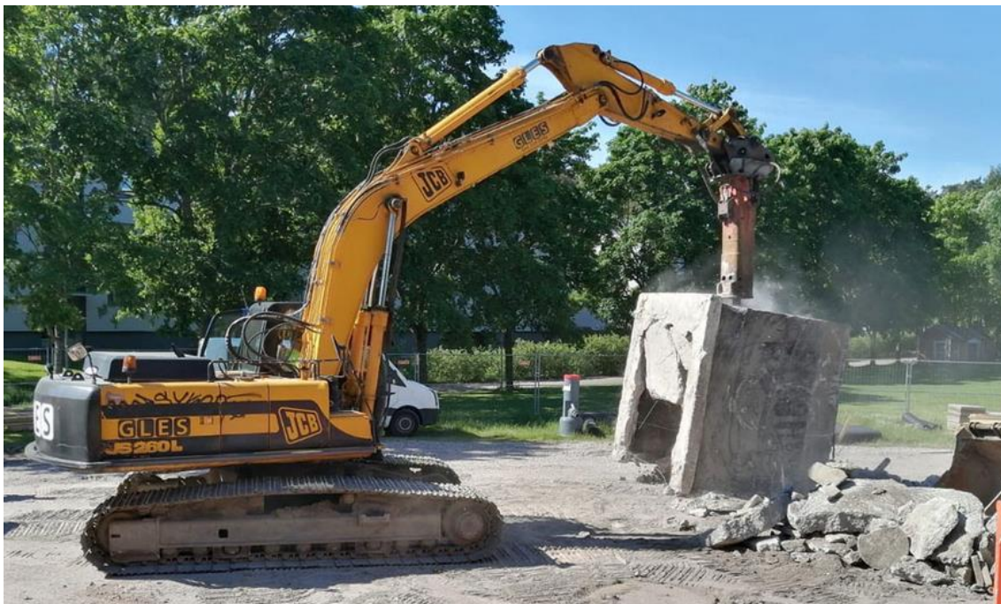
Kuva 4. Betonirakenteen rammerointia. (Gles, rammerointia)
