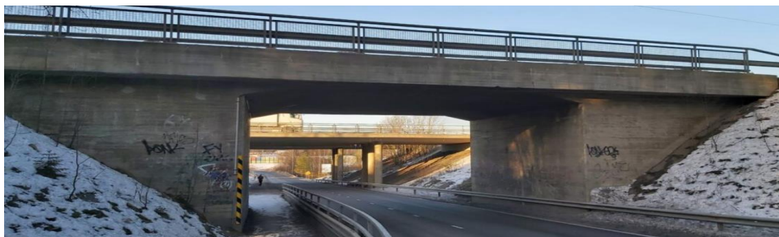
Kuva 8. Vanha siltarakenne etualalla, vasemmassa reunassa näkyy vanha kevyen liikenteen väylä. (Keravan kaupunki)
