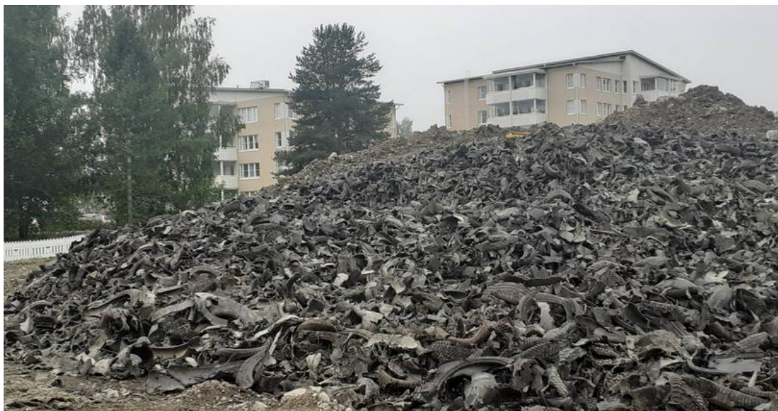
Kuva 3. Rengasleikettä Lempäälässä meluvallissa. (Tampereen yliopisto 2023)
