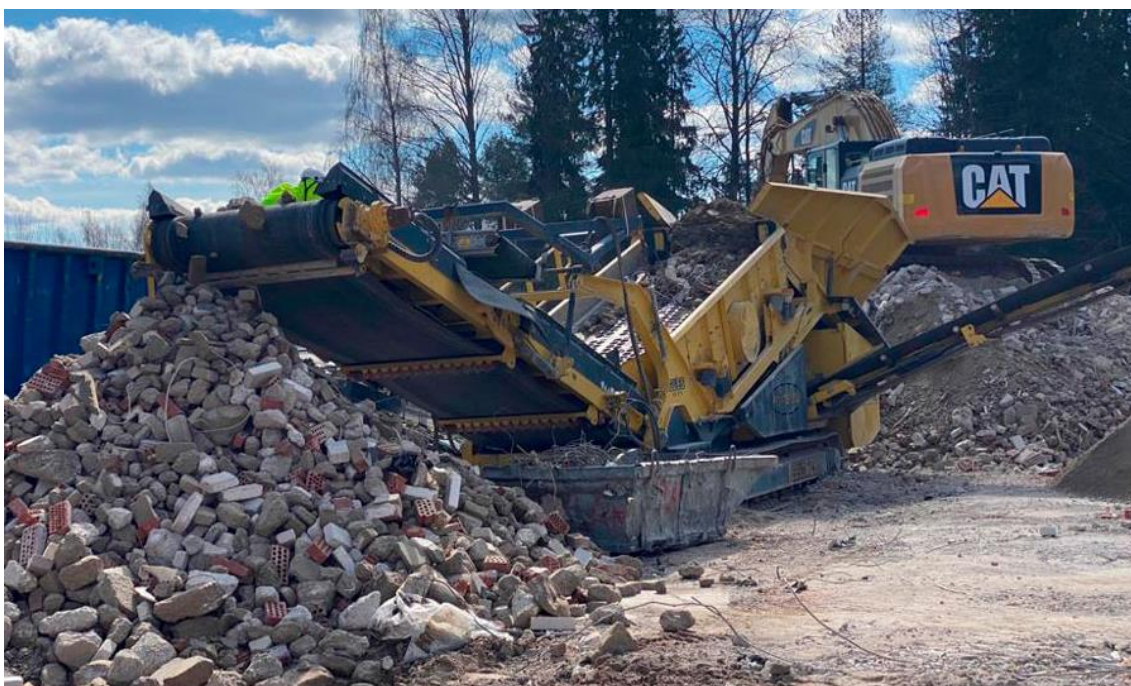
Kuva 5. Betonin seulontaa työmaalla muusta materiaalista. (Gles, kierrätysbetonin seurantaa)
