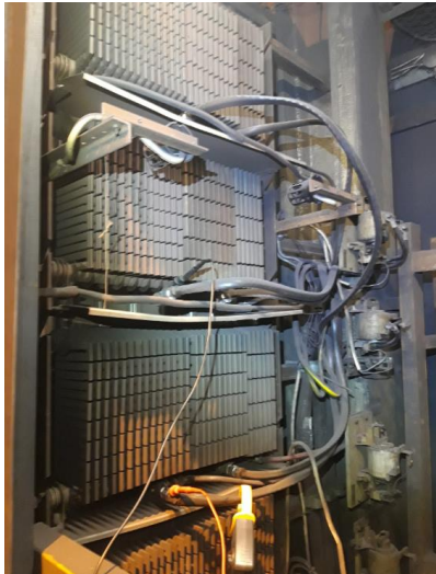
Kuva 3. Liukurengasmootorin roottorivastuspaketti
