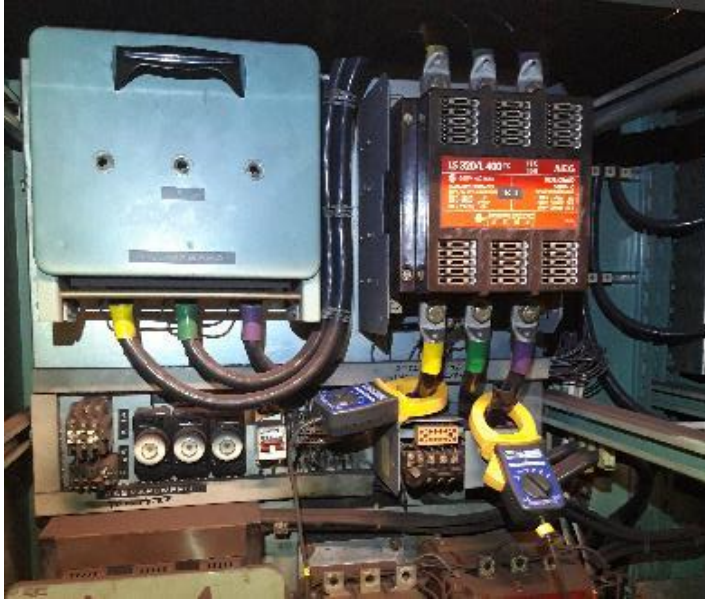
Kuva 6 Sahan moottorilähdön kojeita sekä virranmittauspihtien sijainti.
