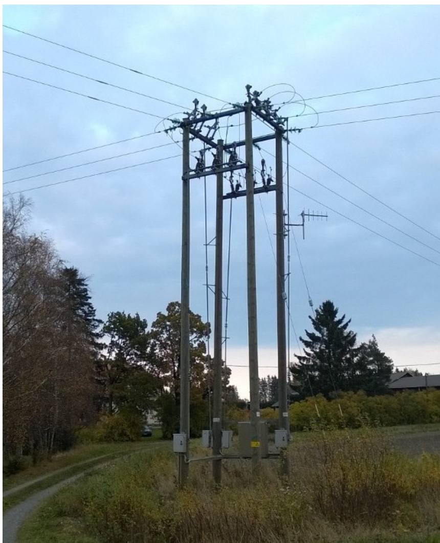
KUVA 6. Kauko-ohjattava erotinasema (Niemi 2014-10-7.)
