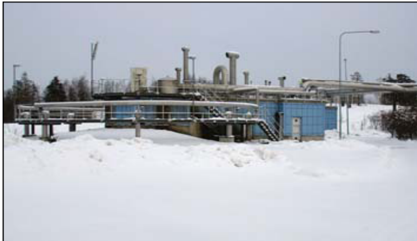
Kuva 7 Viikinmäen laitoksen maanpäällisiä rakenteita. /4/
