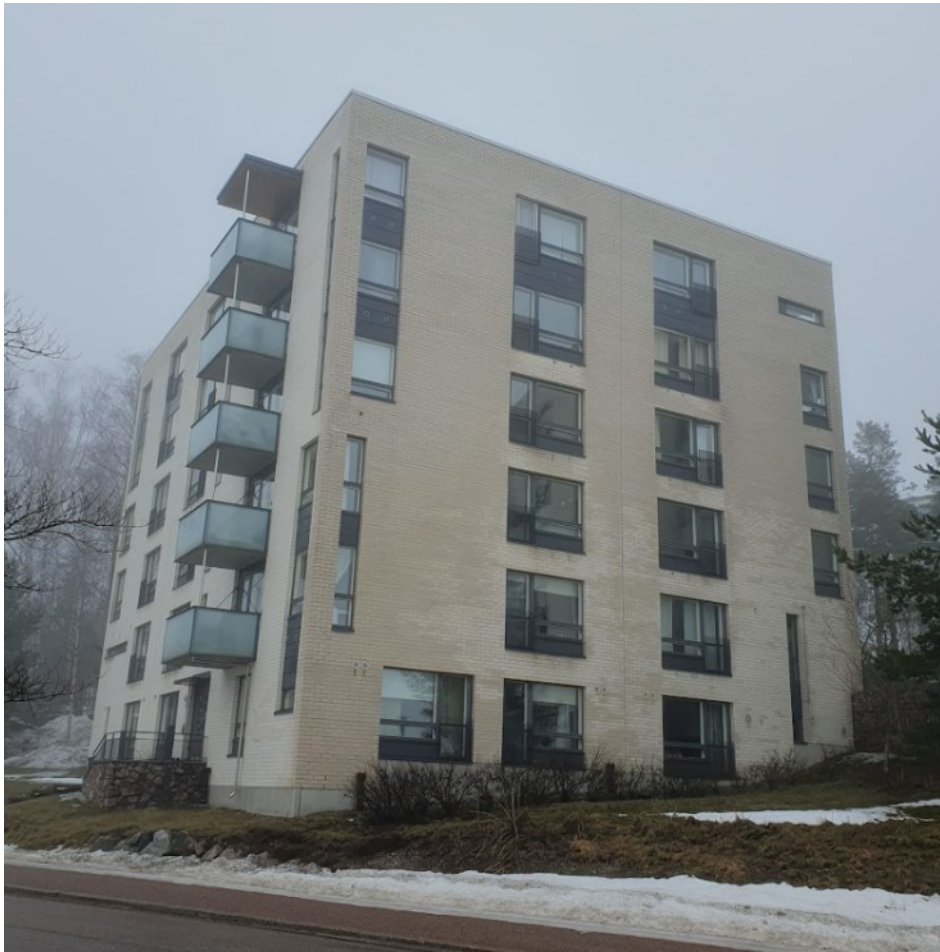
Kuva 24. Viereiset rakennukset ovat vaaleita tiilijulkisivuisia Hoas opiskelija-asuntoja sekä toimistorakennuksia. Rakennuksia yhdistää selkeä aukotuksen jäsentely ja neutraali väritys.
