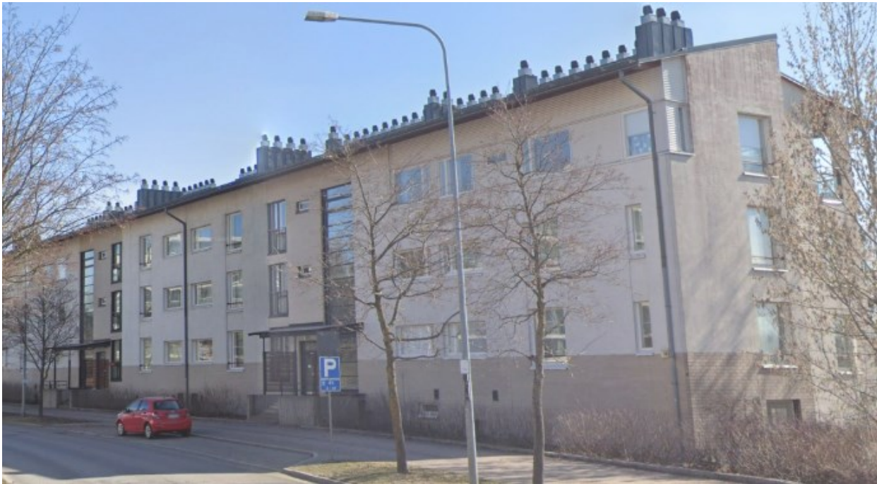
Kuva 20. Painovoimaisen ilmanvaihdon poistoilmahormit näkyvät katukuvassa.
