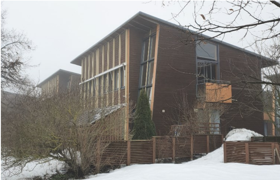
↑ Kuva 48. Kirsti Sivénin Nuppukujan rakennuksissa läntisissä julkisivuissa on suurempi pinta-ala kuin itäisissä, näin massa tuo enemmän auringonvaloa sisälle rakennukseen.
