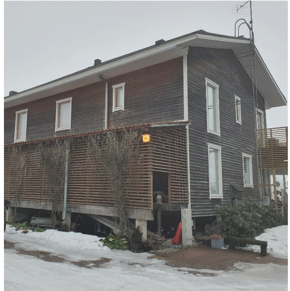
Kuva 50. Juha-Pekka Riittamäen suunnittelema Versokuja 10 matalaenergiatalo, jossa on käytetty eristeenä heinäpaaleja. Korvausilma esilämmitetään tuulettuvan alapohjan kautta. (Oijala 2002: 58.)
