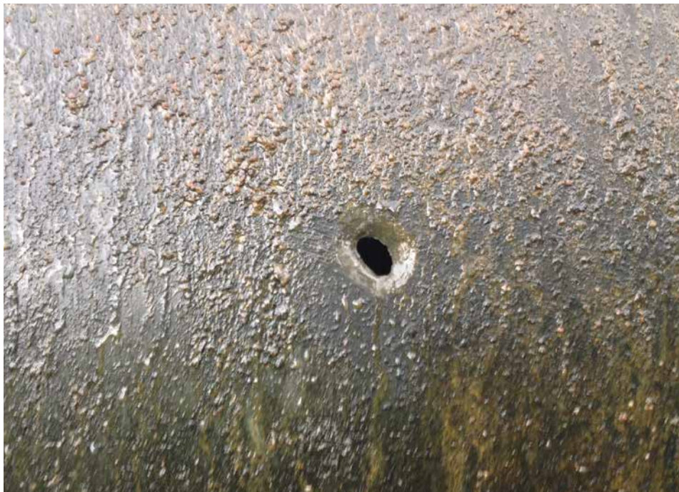
Kuva 8. Maata vasten asennettu öljysäiliö on syöpynyt puhki. (Jake Lehtovirta 2014)
