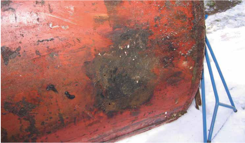
Kuva 9. Öljysäiliössä näkyy kaksi reikää ruostuneella alueella. (Lahden seudun ympäristöpalvelut 2010)
