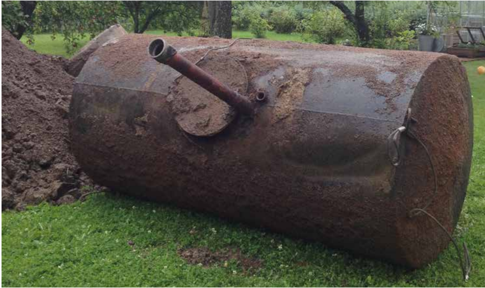
Kuva 7. Vanha maata vasten asennettu öljysäiliö on poistettu maaperästä. (Jake Lehtovirta 2014)
