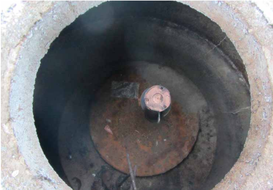
Kuva 4. Maanalaisen öljysäiliön huoltoluukku. (Teija Tohmo 2013)
