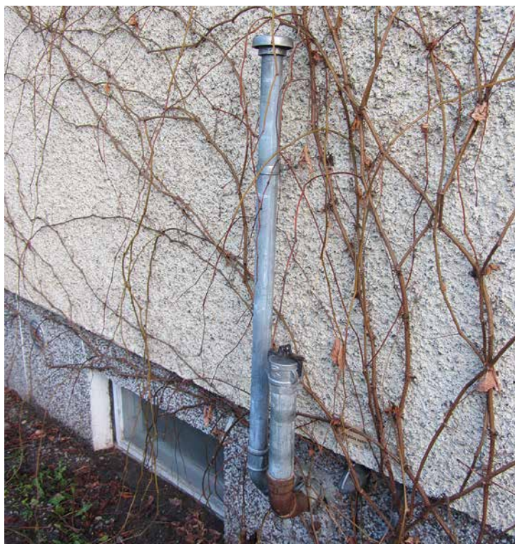
Kuva 2. Kuvassa näkyvät suojahatulla varustettu ilmaputki (vasemmalla), liitinnipalla ja lukittavalla kannella varustettu täyttöputki sekä ylitäytönestimen asennettuna sokkeliin (oikealla). Kilpi "Kevytöljy" kuuluu asentaa täyttöputken suun läheisyyteen. (Teija Tohmo 2013)
