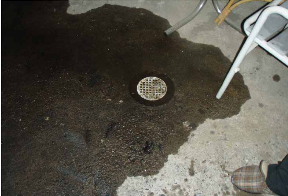
Kuva 15. Öljyvahinko kattilahuoneessa. (Kanta-Hämeen pelastuslaitos 2013)
