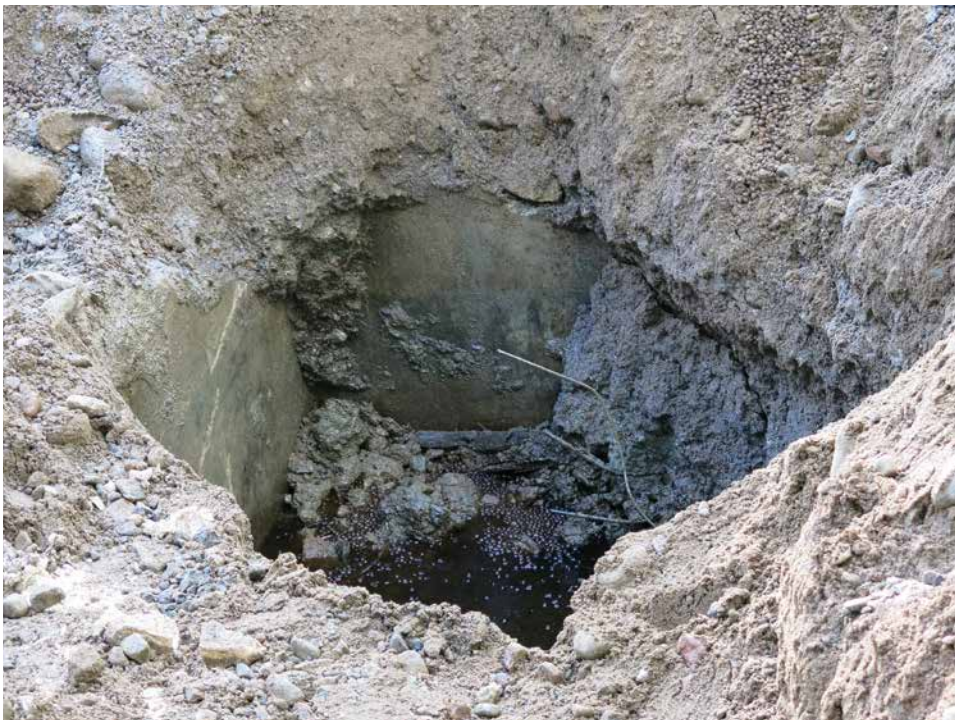
Kuva 10. Öljyä näkyvissä betonibunkkerissa. Maanalainen öljysäiliö poistettiin käytöstä maanalaisten paluuputken rikkoutumisen takia ja korvattiin sisätiloihin asennetulla uudella säiliöllä. (Päivi Kärnä 2013)
