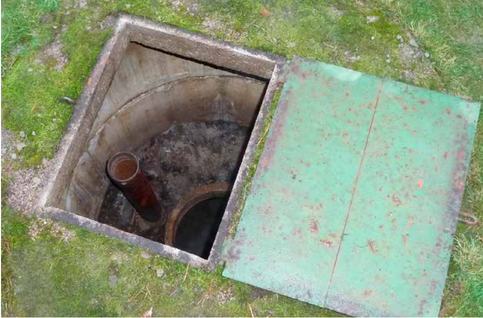
Kuva 5. Maanalaisen öljysäiliön huoltoluukku. [Ramboll Finland Oy 2013]
