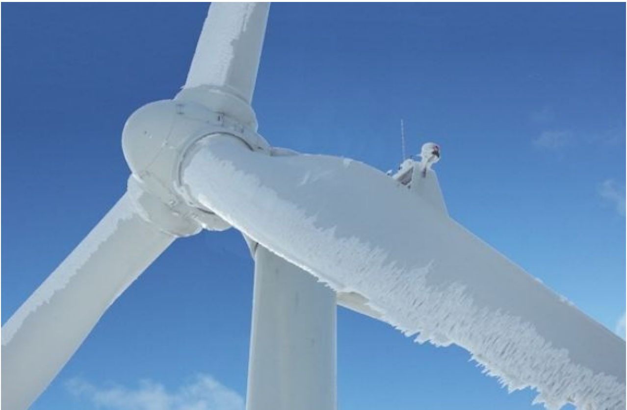
Kuvio 18 Jäätynyt tuulivoimalan lapa (Okka 2022)
