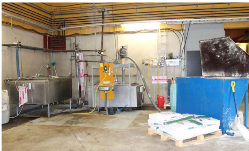
KUVA 3. Juomanvalmistusjärjestelmä. Oikealla sininen maitojauhesäiliö, keskellä maidon tekotankki ja vasemmassa reunassa maitojuomasäiliö. (Nöjd 2014-08-30)
