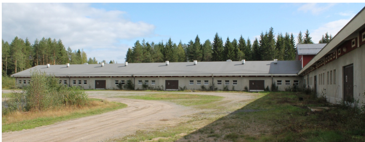
KUVA 2. Ylä-Savon Terni Oy:n navettarakennus. (Nöjd 2014-08-30)
