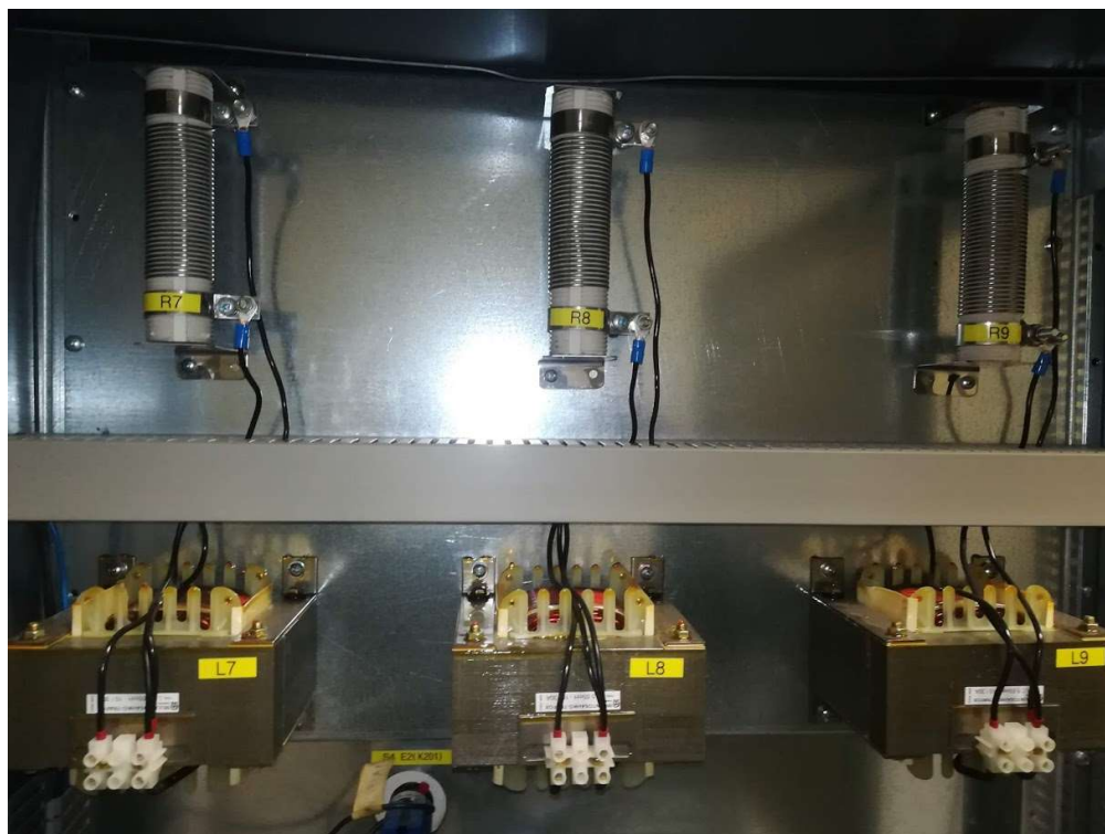
KUVA 3. Vastukset ja kelat mallintavat johdon sähköisiä ominaisuuksia
