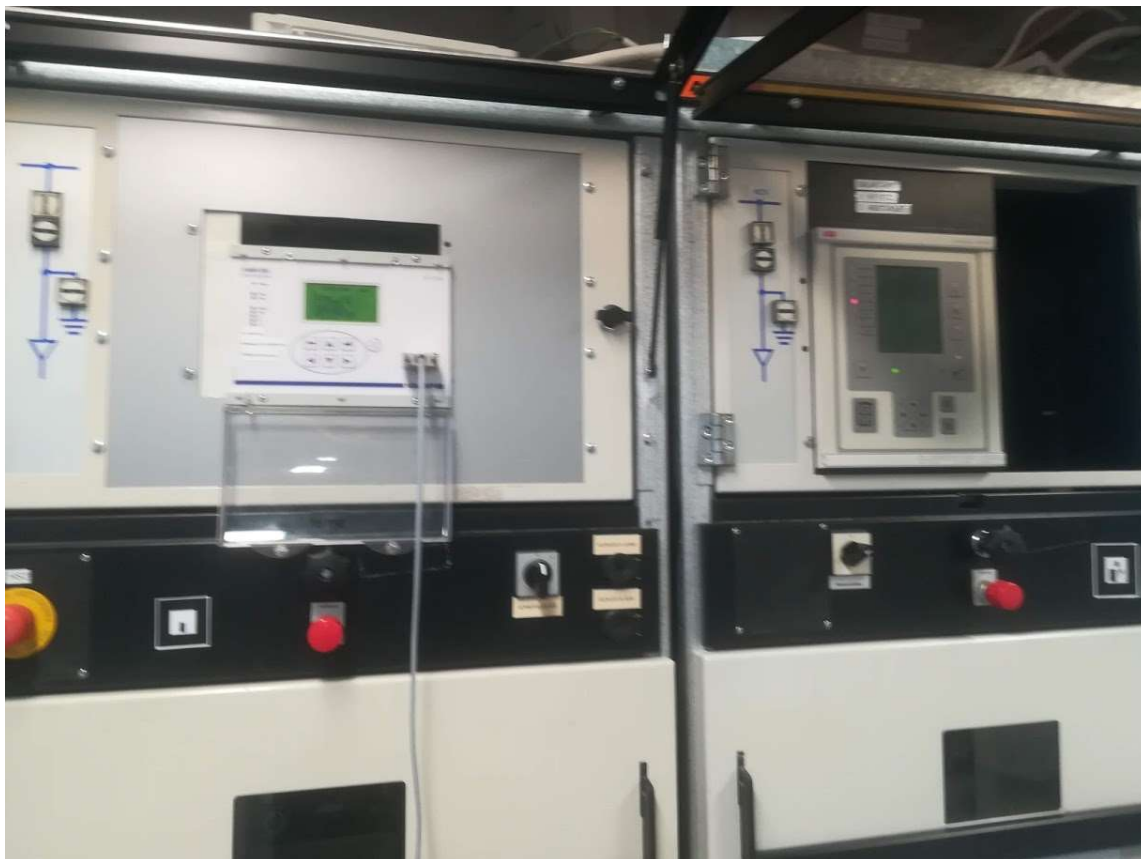
KUVA 10. Molemmat releet asennettuna, vasemmalla VAMP ja oikealla ABB
