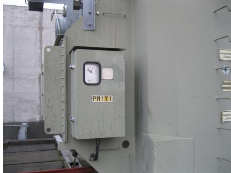
Kuva 38. PM1:sen käämikytkimen ohjainkotelo
