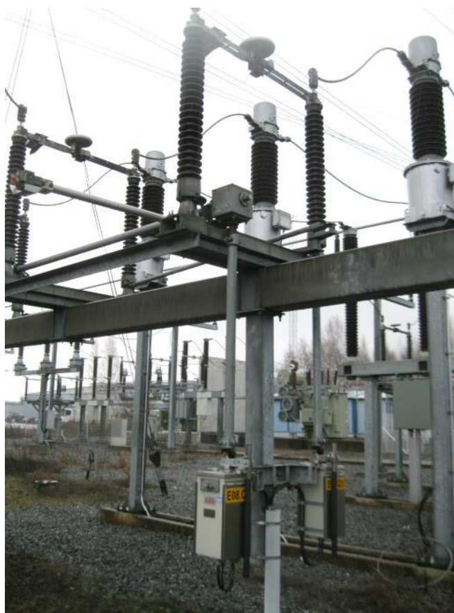
Kuva 20. Maadoituserotin
