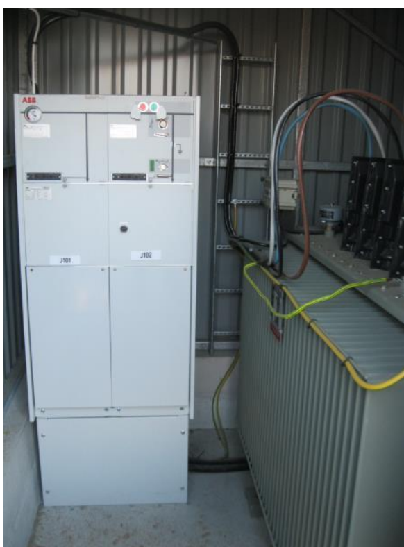
Kuva 1. Oikealla sammutuskuristimen tähtipistemuuntaja, joka toimii myös omakäyttömuuntajana
