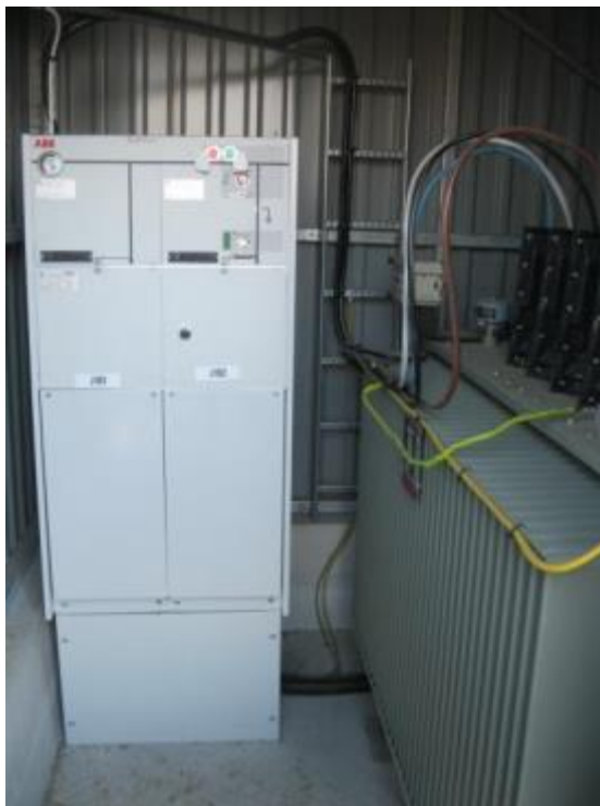
Kuva 32 Molemmista kopeista löytyy SF6-kojeisto (vas.) ja 100 kVA sammutuskuristimen tähtipistemuuntaja (oik.)
