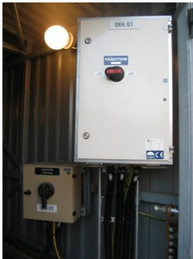
Kuva 34. Omakäyttösähkön valintakytkin kopissa J42
