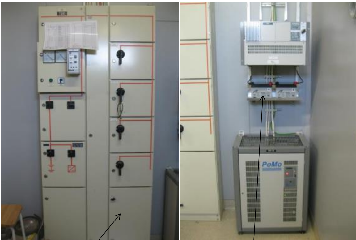
Kuva 4. Sähkösäntämän varaaja ja tasajännitelähde
