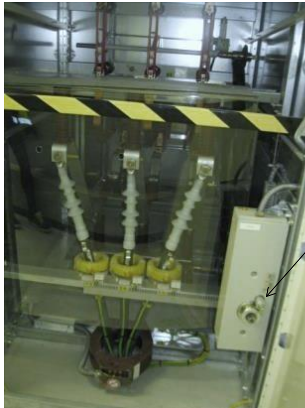
Kuva 12. Kuva kennon takaa. Oikealla kiskonerottimen Q2 moottori, jossa myös ohjauksen paikka. Kuvassa näkyvät myös maadoituspallo.
