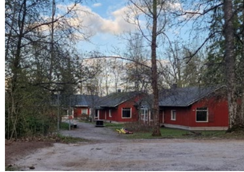
Kuva 4: Kuvassa tyhjiällä oleva, purettava huoltokoti. Kuva: Meri Rajamäki
