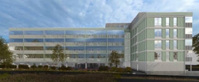
Kuva 3. Rakennus sisäpihan puolelta.
