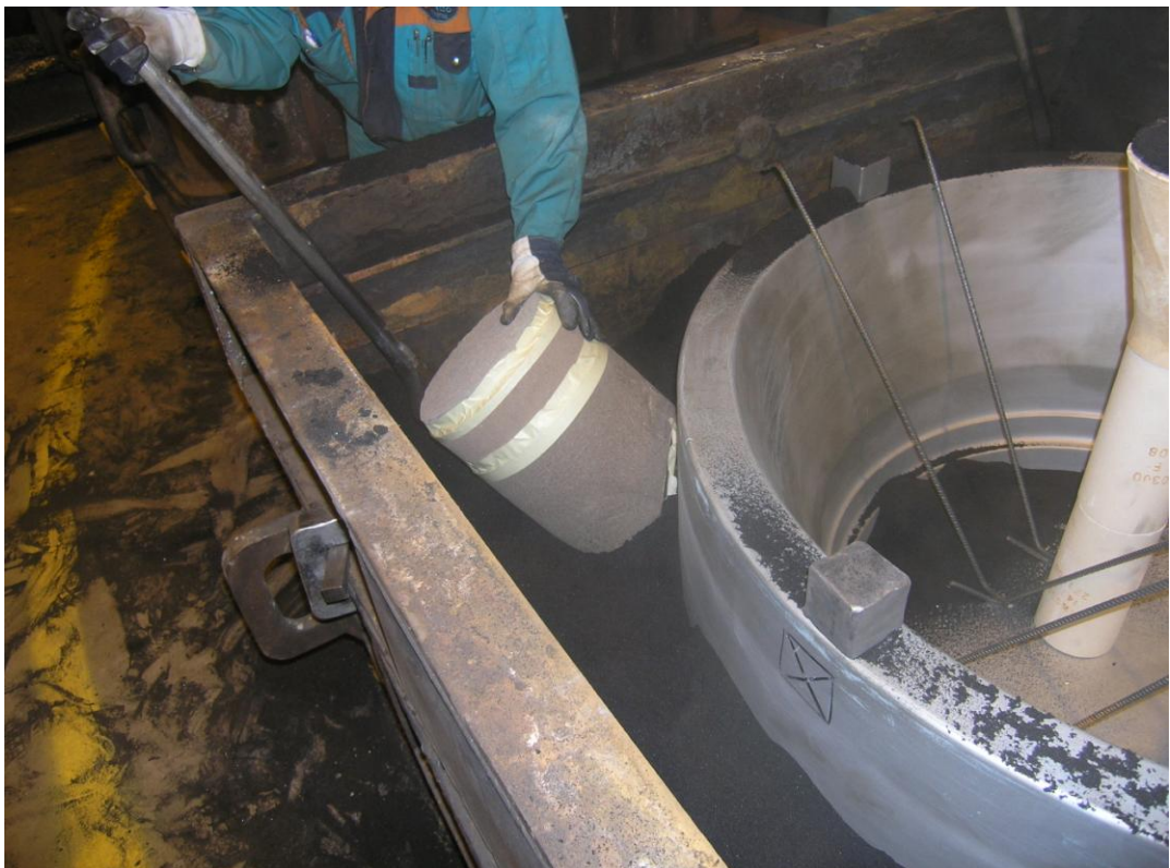
Kuva 15 Hiekan tiivistäminen eristeholkin ympärille
