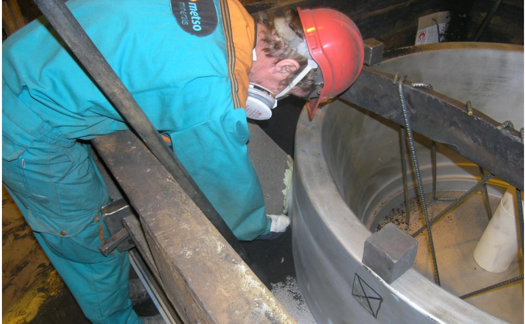
Kuva 14 Eristeholkin asettaminen paikoilleen
