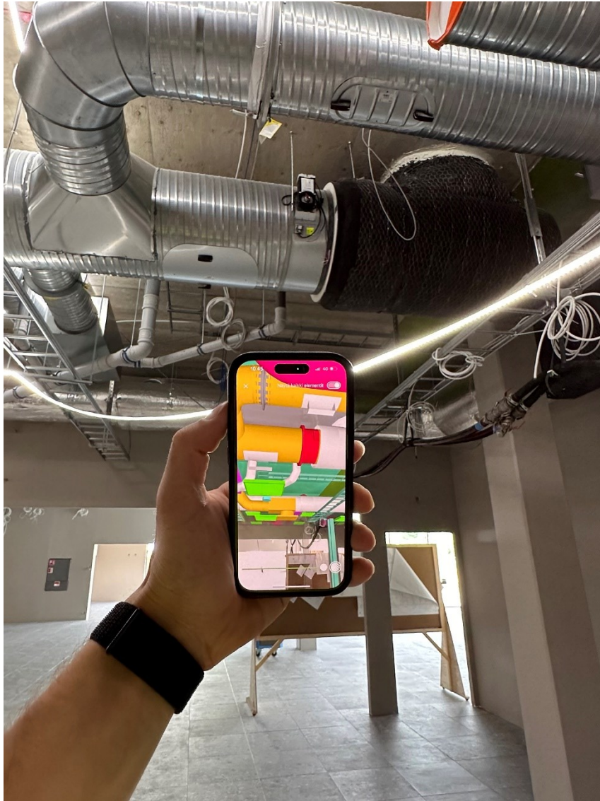
Kuva 6. Esimerkki AR-ominaisuuden käytöstä (työmaan kuva-arkisto 2024).
