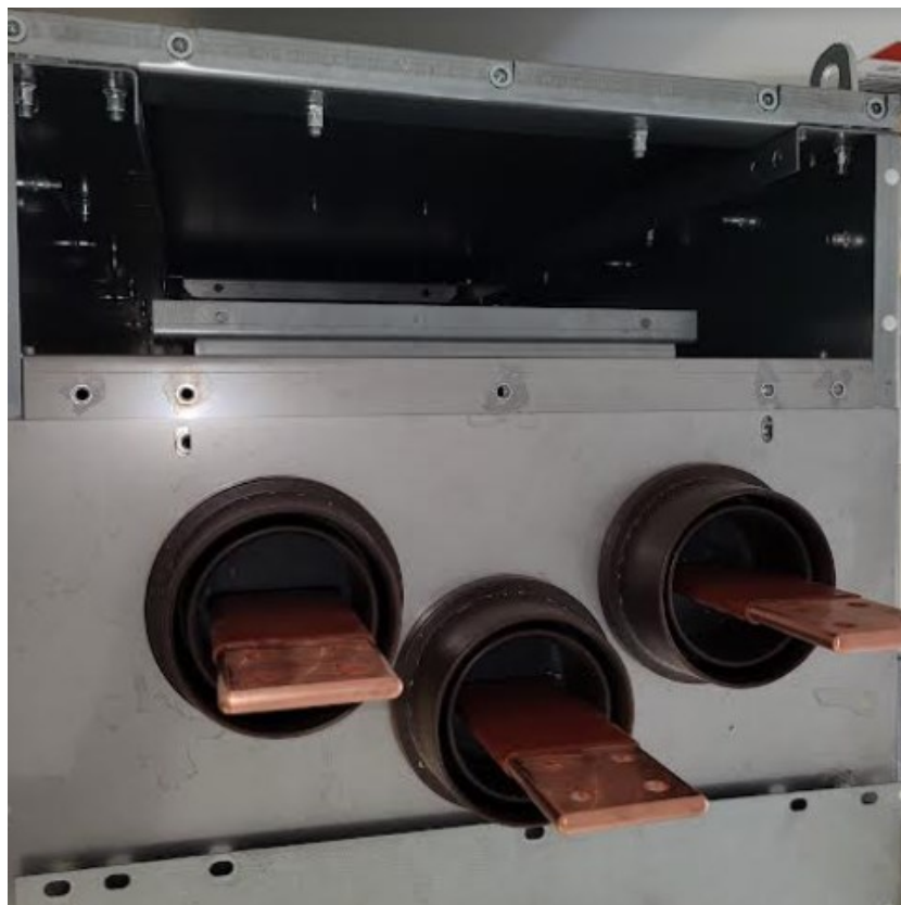
Kuva 14. Opetuskojeiston yläpuoli, kokooja kiskot ja avattu paineenpurkausluukku.
