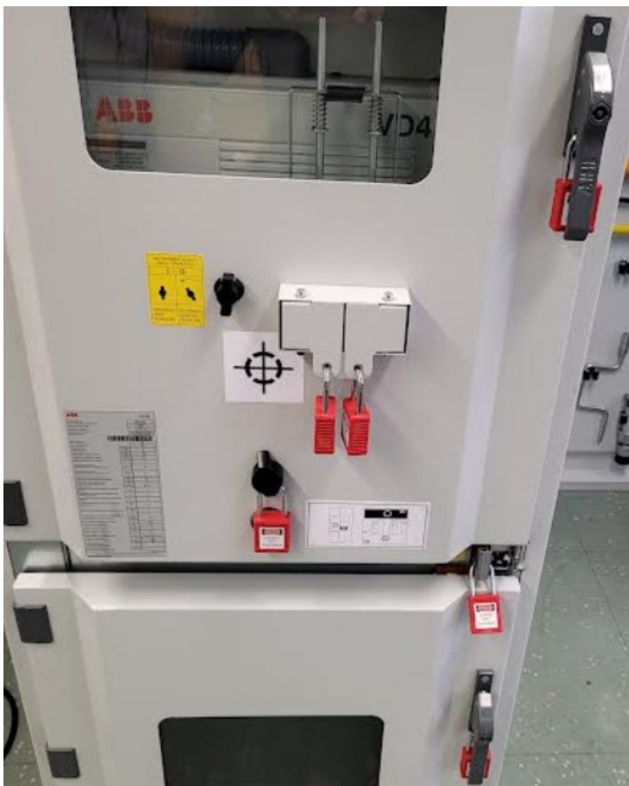
Kuva 2. Opetuskojeistoon asetettuja turvalukkoja, kytkentäkieltokilpi puuttuu.
