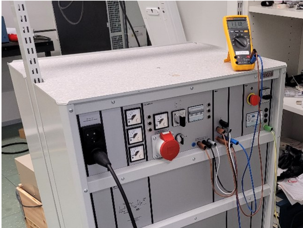
Kuva 11. Siirrettävä säätömuuntaja tasasuuntauksella, sopiva tasajännite nähdään helposti yleismittarilla.
