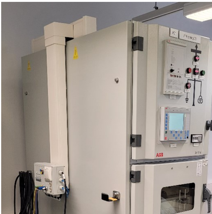
Kuva 15. Asennuskouru valmiina.
