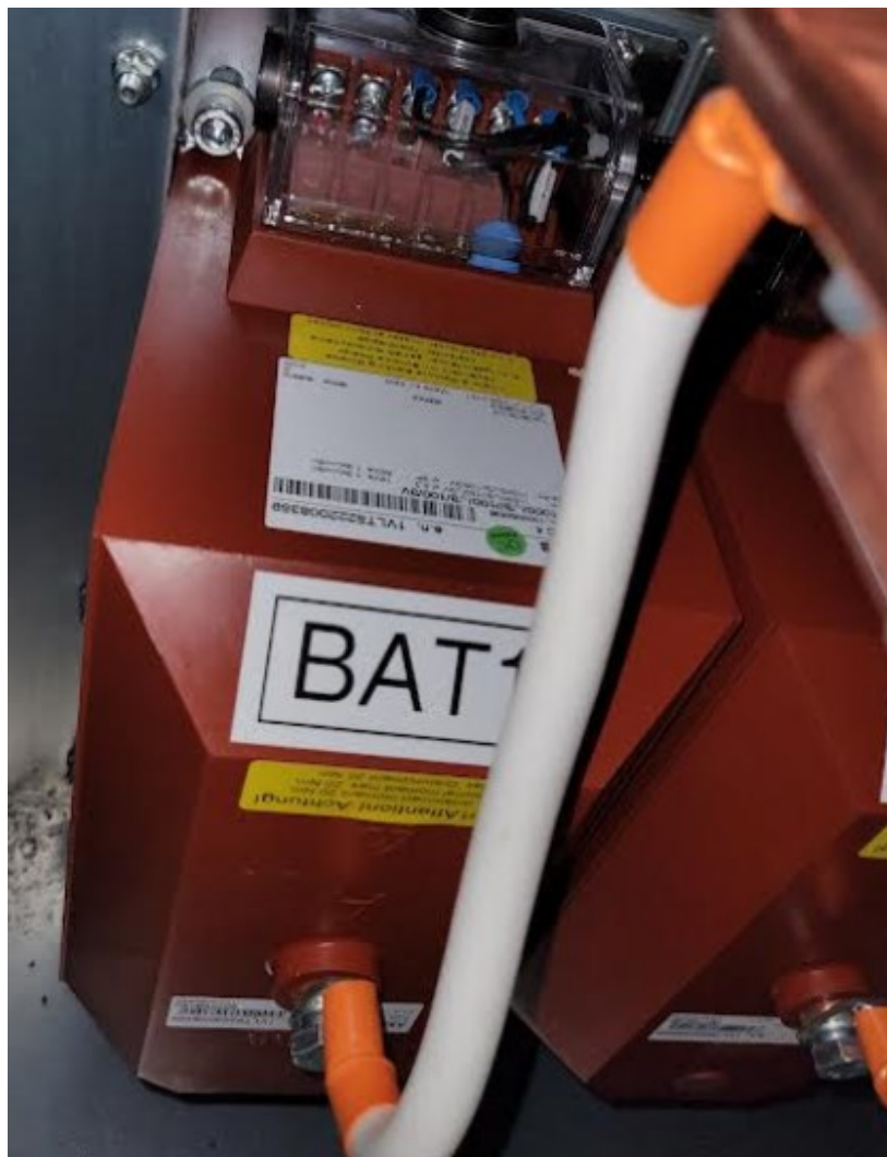
Kuva 7. Opetuskojeiston jännitemuuntaja. BAT1 -koodi tulee IEC-standardista 81346–2.
