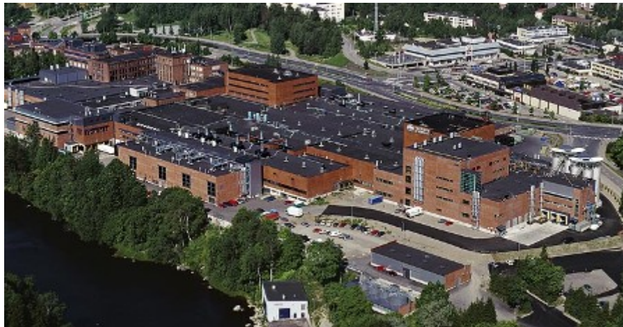
Kuva 1 Nokialla sijaitseva tehdas
