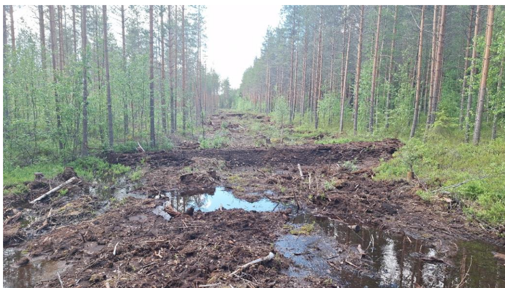
Kuva 31. Puustoa poistettu ojan ympäriltä ja se täytetty ja pintavallitettu. (Järvinen 2024)
