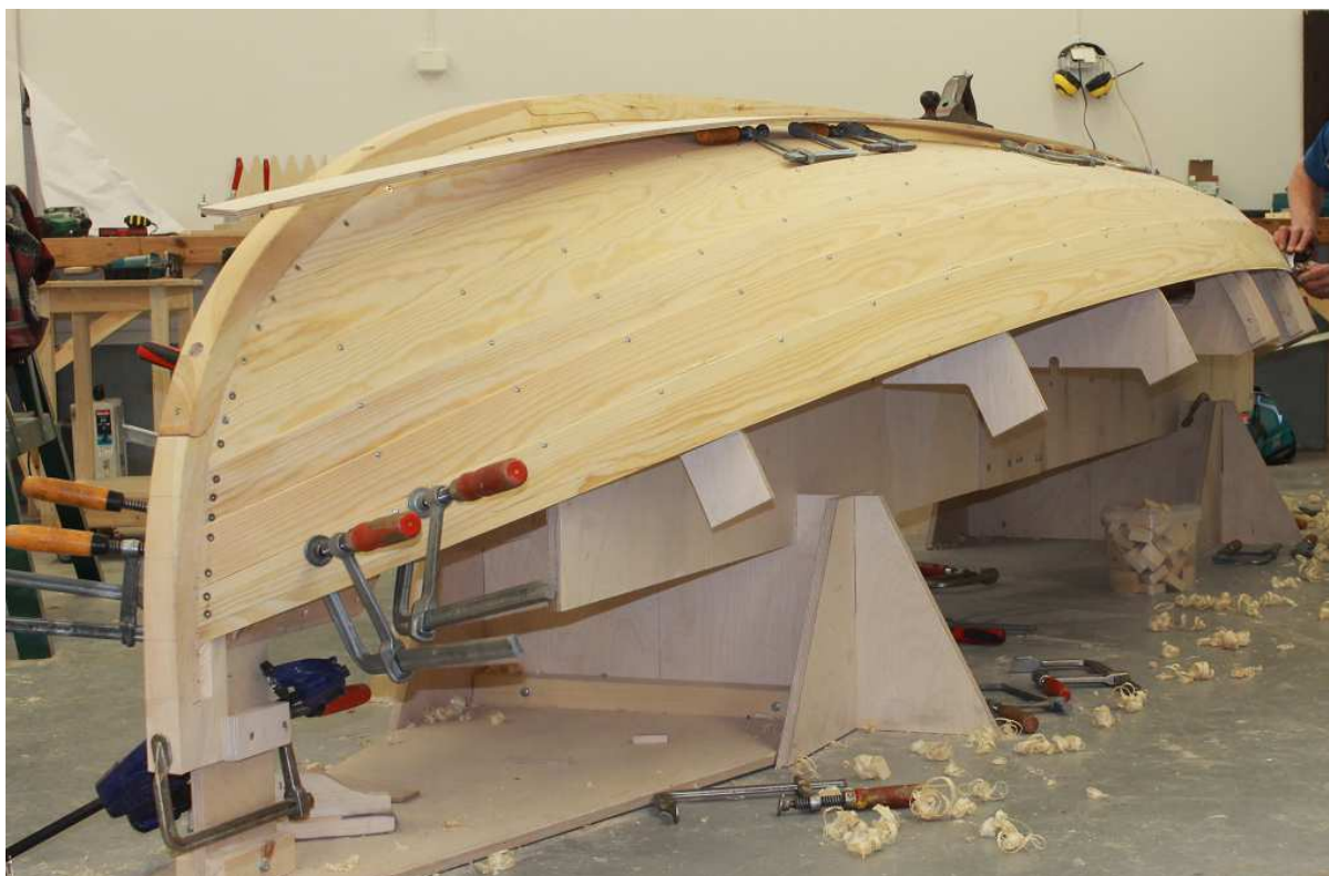
Kuva 8: Lautojen asennusta Ingmanilla, kyntteen veisto käynnissä (Arbelius, 2014)
