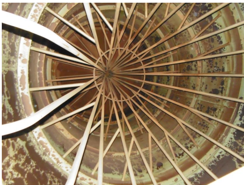
Kuva 12. Imuputket meesasuoitimen sisäpuolelta (Kuva: Sami Seppänen)
