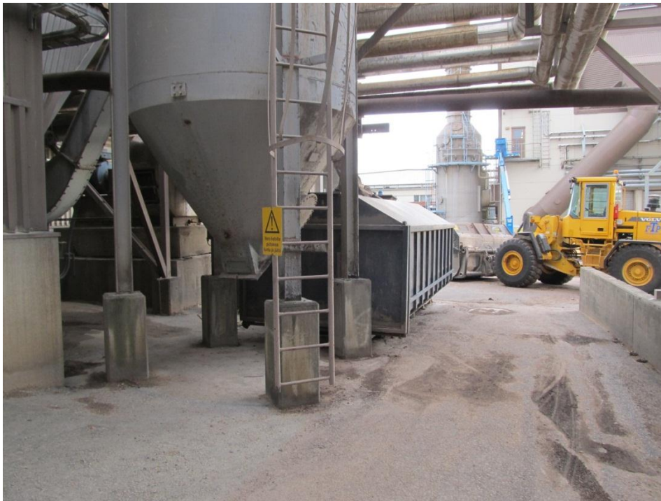
KUVA 7. Kumpuniemen Voima Oy:n lentotuhkasiilo (Kuva: Jenni Mäkinen 2014)
