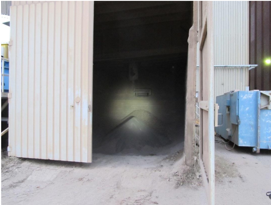
KUVA 2. Mäntän Energia Oy:n hiekkabunkkeri (Kuva: Jenni Mäkinen 2014)
