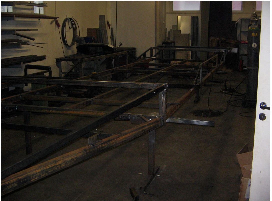
Kuva 16. Rungon valmistus alkuvaiheessa
