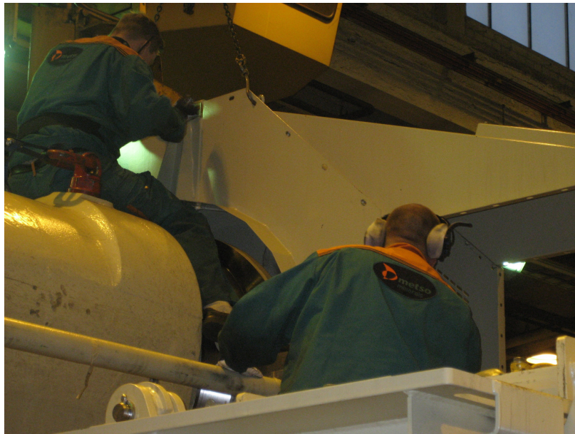
Kuva 13 Asentajat murskaimen päällä kiinnittämässä suoja
