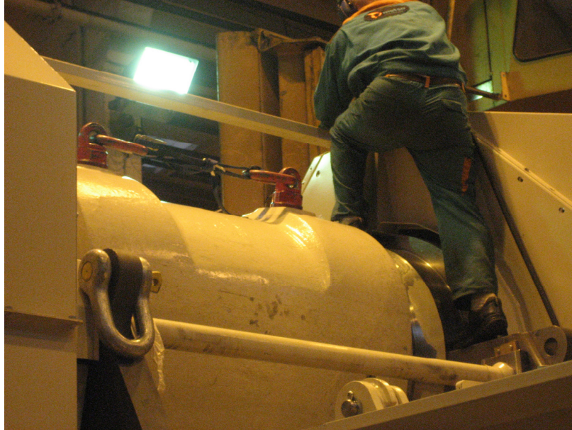
Kuva 14 Asentaja murskaimen päällä kiinnittämässä välitankoja
