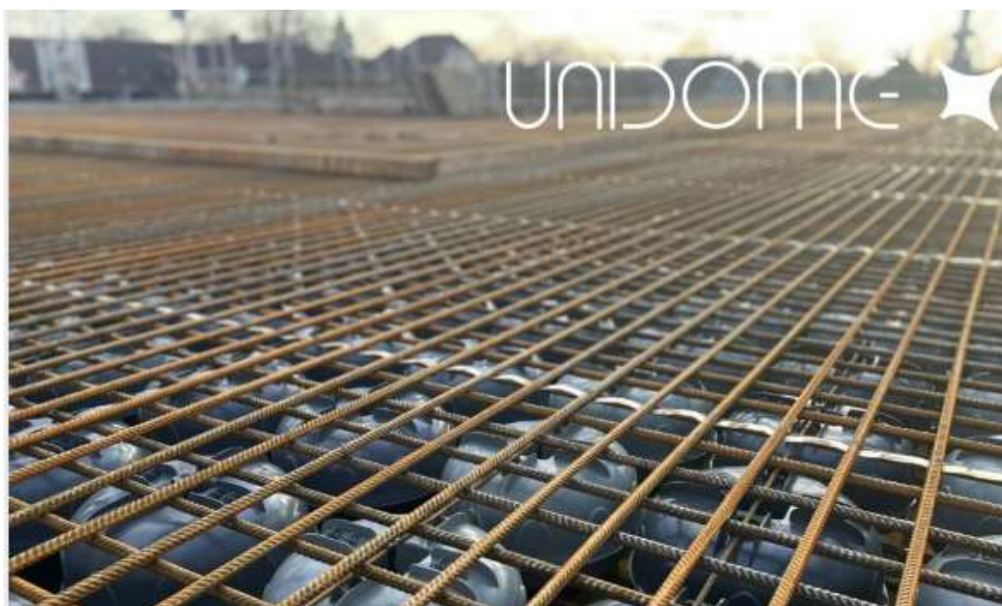
Kuva 6 Unidome-menetelmä käytössä (Sulin Oy. 2024)
