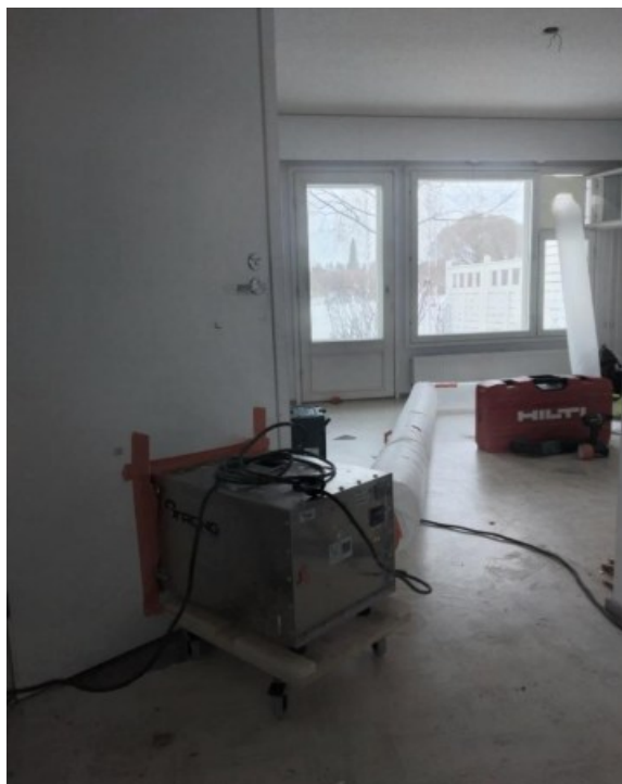
KUVA 4. Alipaineistaja purettavan tilan ulkopuolella. (Vironen 2024, CC BY-SA)
