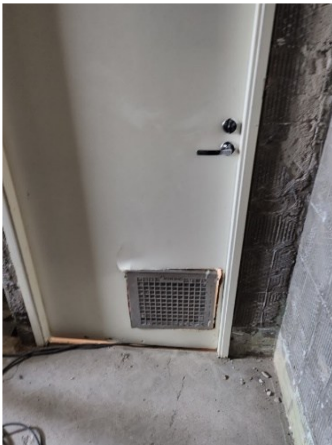
KUVA 5. Alipaineistaja kuvattuna purettavan tilan sisäpuolelta (Vironen 2024, CC BY-SA)
